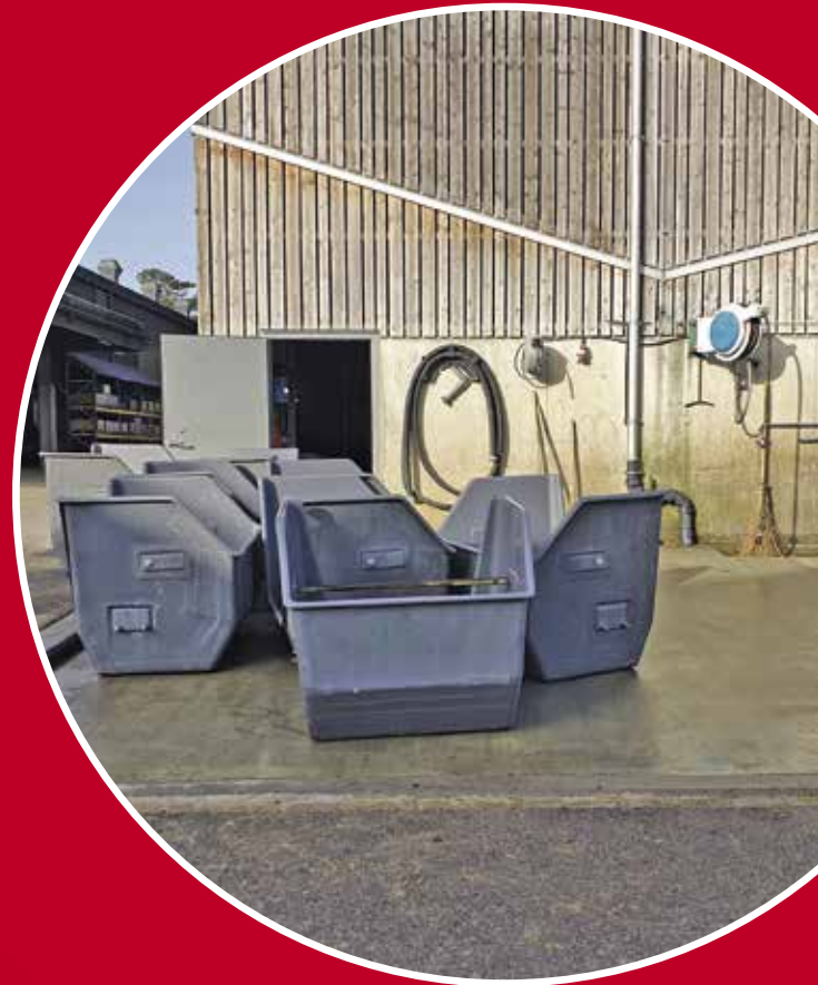
Befüll- und Waschplatz beim Strickhof in Lindau
