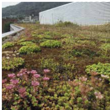
Flachdach mit natürlicher Begrünung
