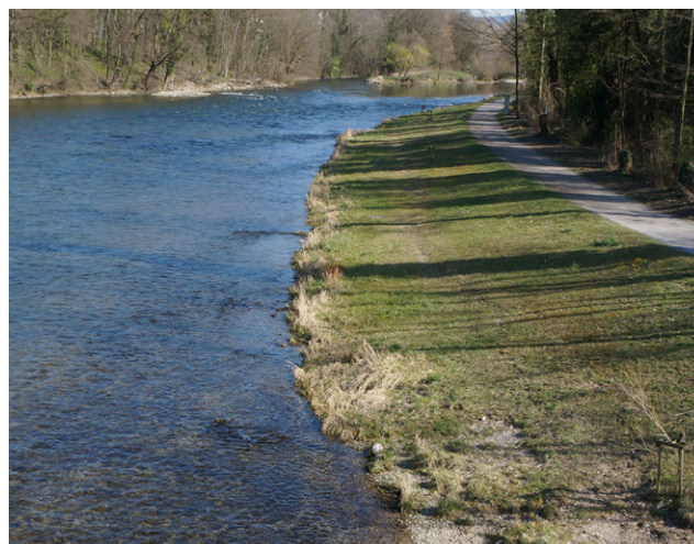
Als Flachufer revitalisiertes linkes Ufer.
