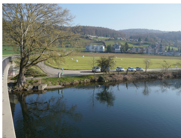
Teilweise kompletter fester Verbau um die Brücke am rechten Ufer; sonst Ufer grob befestigt.
