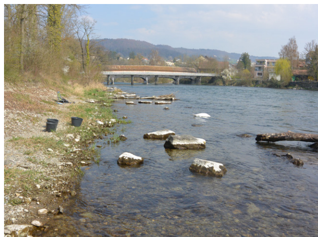
Als Flachufer mit Störsteinen im Flachwasser ausgestattete 100 m lange Revitalisierung am rechten Ufer.
