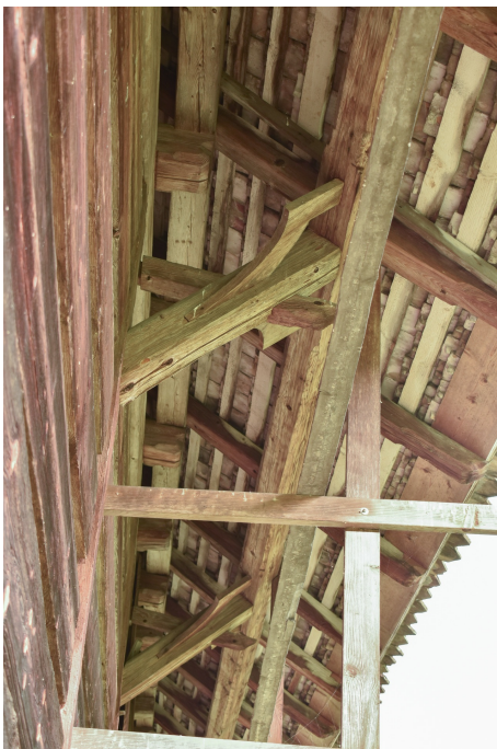
Feldscheune Burstel, Vordachstützen an der Südostfassade, 04.11.2022 (Bild Nr. D100692_92).
