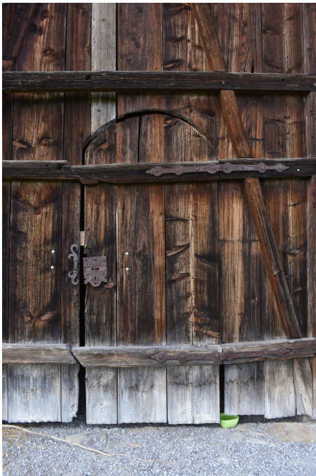
Feldscheune Burstel, Mannstür im Tenntor, Ansicht von SO, 04.11.2022 (Bild Nr. D100692_91).
