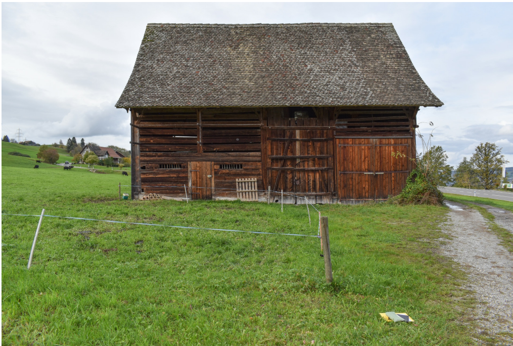
Feldscheune Burstel, Ansicht von SO, links der Stallbereich, darüber ein Heuboden, 04.11.2022 (Bild Nr. D100692_90).
