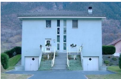
Treppe unwichtig , alle Seitenmauern sind nicht zu erheben
