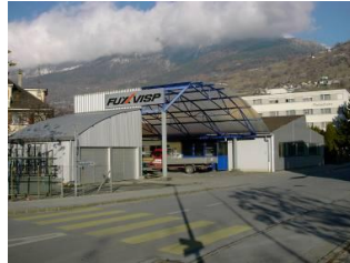
Unterstände Tiefe > 4.00 m
