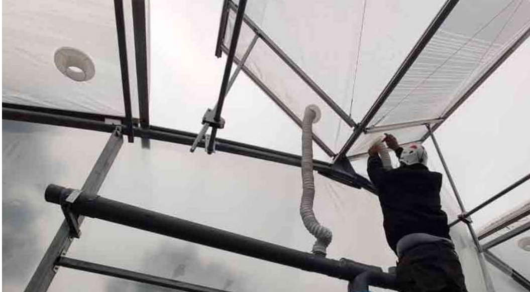
Abbildung 6 Folienhaus mit aufgeblasener Doppelfolie [Quelle: www.gvz-rossat.ch ]
