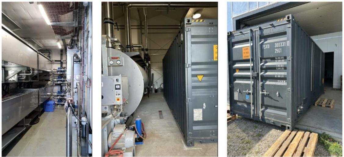
Abb. Serverheizung «Green Heating Container 600 kW» (Quelle: K51 AG, 2023)
