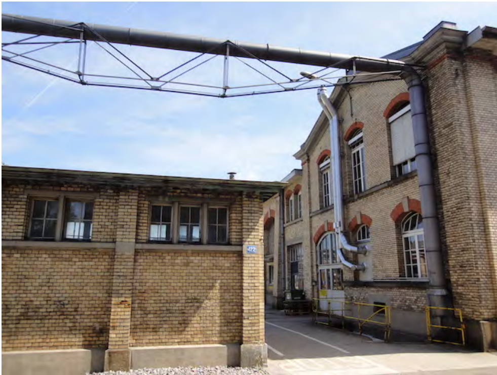
Hauptwerkstätten, Absauganlage (261AUABSAUG00001) an der Westecke der Wagenwerkstätte I (261AU03362), links das Abortgebäude (261AU03364), 17.07.2019 (Bild Nr. D101369_33).
