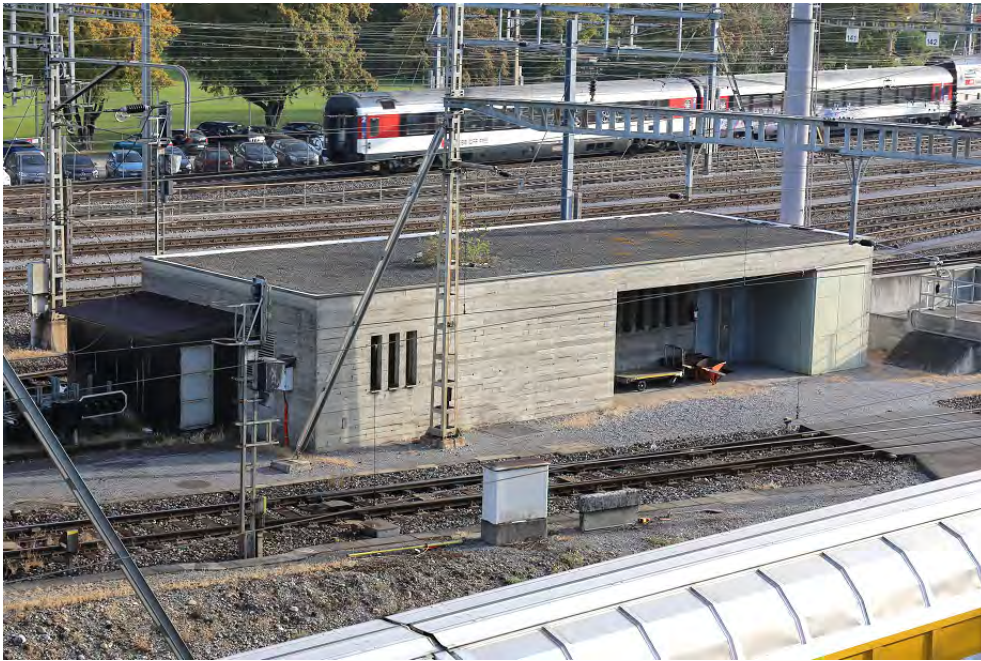
«Schnellgut-Stammbahnhof» Zürich Altstetten, Rangier- und Gleisbremsengebäude (261AL00081) mit der Rangierfunkantenne (rechts), Ansicht von SW, 25.10.2018 (Bild Nr. D101353_21).
