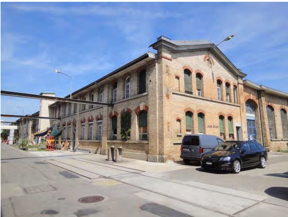
Hauptwerkstätten, Wagenwerkstätte I (261AU03362), Ansicht von S, 17.07.2019 (Bild Nr. D101369_27).
