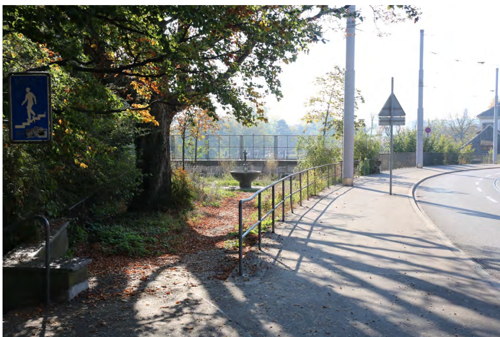
«Seebahneinschnitt», Engetunnel, Südportal mit Grünanlage (261ENTUNNEL00004), Ansicht von N, 17.10.2018 (Bild Nr. D101369_82).
