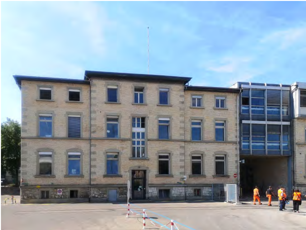
Hauptwerkstätten, Verwaltungsgebäude (261AU03103), Ansicht von NO, rechts der zweigeschossige Verbindungsgang zum Magazingebäude und Portierhaus (261AU03103), 17.07.2019 (Bild Nr. D101369_11).
