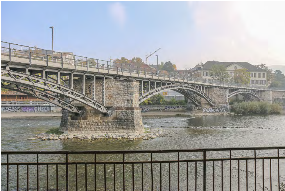
Lettenviadukt, Limmatbrücke (261IQBRUECKE00008), Ansicht von S, 20.10.2018 (Bild Nr. D101138_64).
