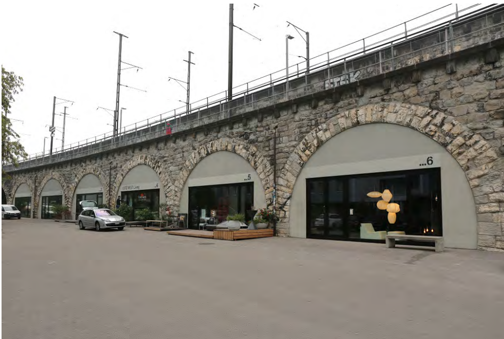
Lettenviadukt, Hausteinbögen und Strassenunterführungen (261AUVIADUKT00002), Ansicht von NO, 20.10.2018 (Bild Nr. D101138_48).
