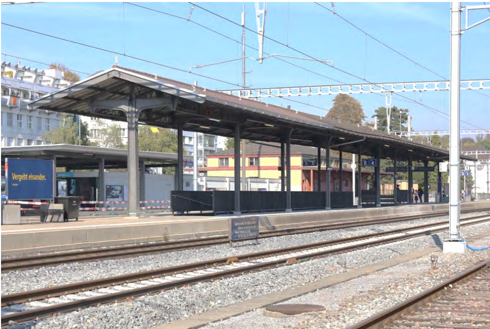
Bahnhof Zürich Wollishofen, Perrondach (261WOPERRON00348), Ansicht von SO, 18.10.2018 (Bild Nr. D101139_18).
