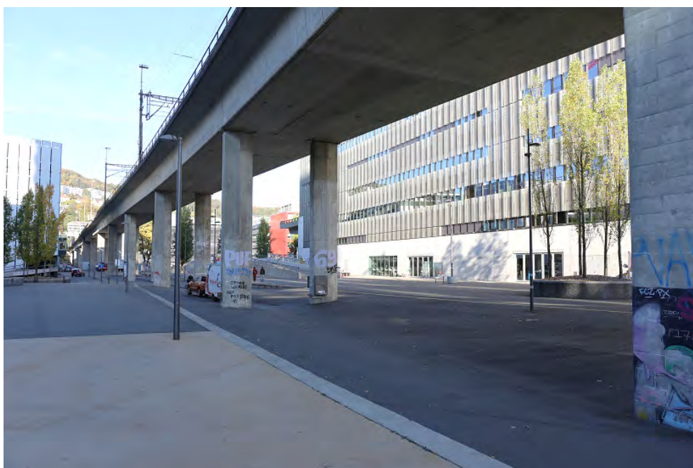
Hardturmviadukt, gerader Teil (2611QHARDTU00003), Ansicht von SW, 25.10.2018 (Bild Nr. D101138_79).
