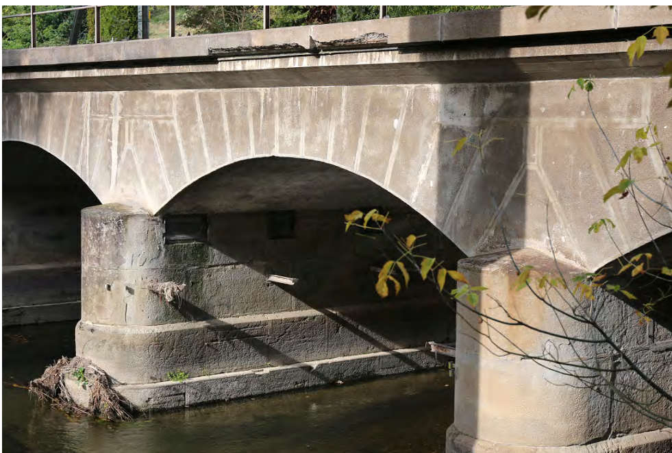
Glattbrücke, Ansicht von SO, 26.10.2018 (Bild Nr. D101354_82).
