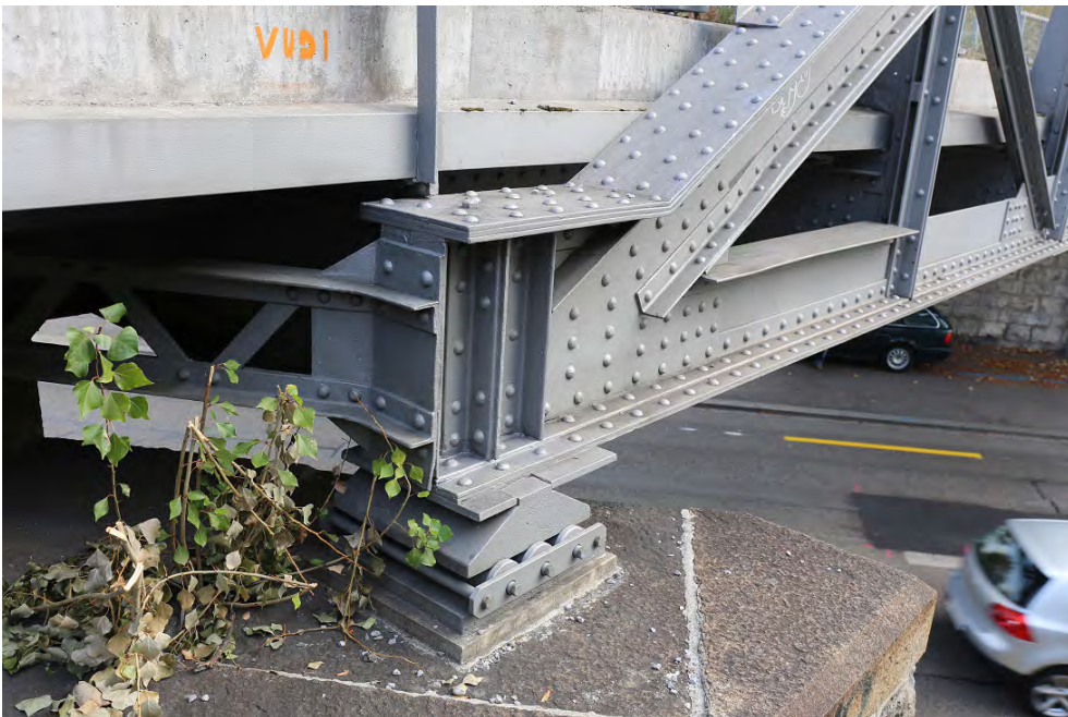
Lettenviadukt, Strassenunterführung Sihlquai (261IQBRUECKE00006), Rollenwiderlager (Detail), 20.10.2018 (Bild Nr. D101138_59).
