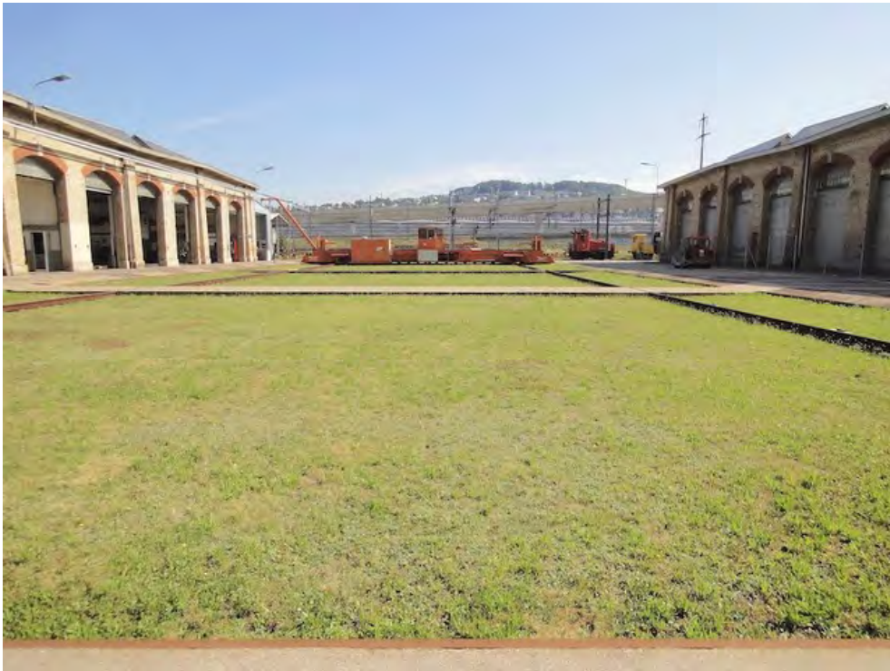
Hauptwerkstätten, Schiebebühne West (261AUSCHIEBE00001) zwischen den Wagenwerkstätten I (261AU03362) und II (261AU00082), Ansicht von SW, 17.07.2019 (Bild Nr. D101369_35).
