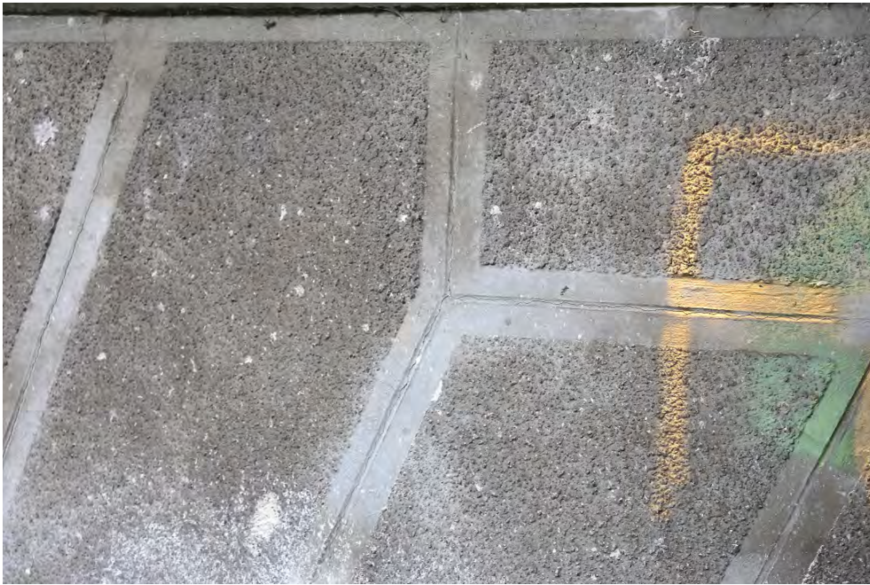
Glattbrücke, Oberflächenbearbeitung des Zementverputzes (Detail), 26.10.2018 (Bild Nr. D101354_82).
