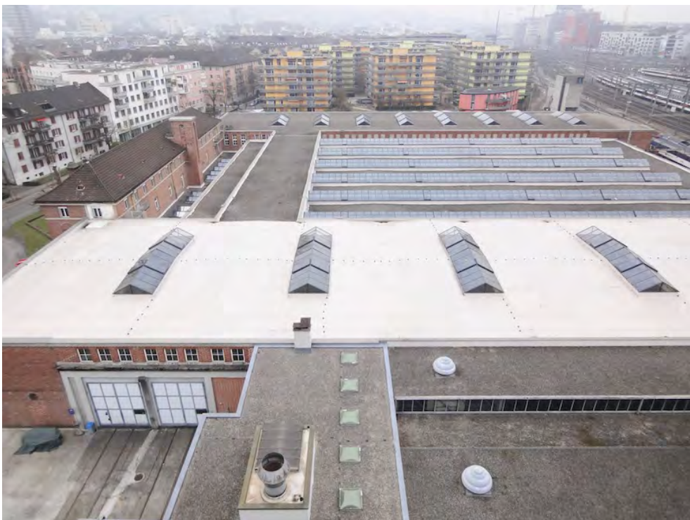
«Lokomotivremise G», links oben das Dienstgebäude (261AUDIENST04007), rechts davon die Standhalle (261AU04007), flankiert von den beiden Schiebebühnenhallen, Ansicht von NW, 21.12.2016, (Bild Nr. D101395_05).
