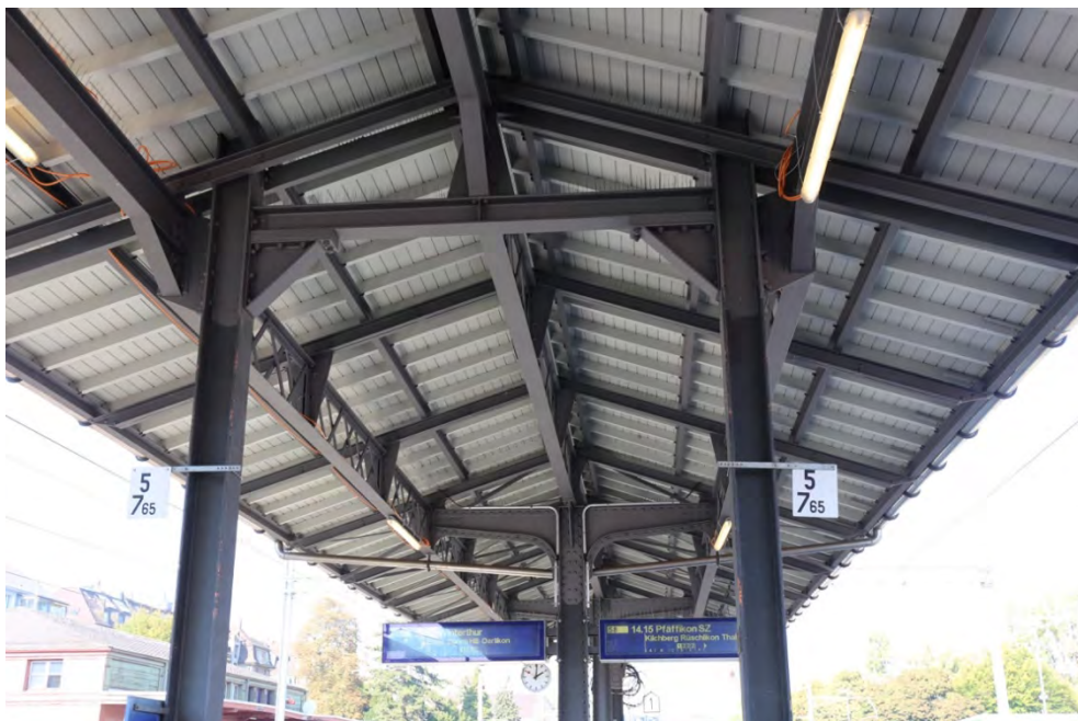
Bahnhof Zürich Wollishofen, Perrondach (261WOPERRON00348), Dachuntersicht mit urspr. Einzelstützen und Fachwerk-Längsträgern (hinten), vorne eine neue Doppelstütze und Walzprofil-Längsträger, 18.10.2018 (Bild Nr. D101139_08).
