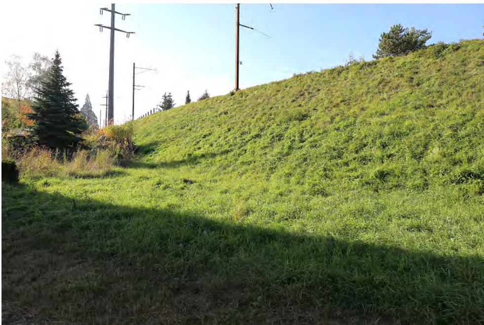
«Konkurskurve», Erddamm der Nationalbahn, nordöstlicher Bereich, Ansicht von SO, 26.10.2018 (Bild Nr. D101354_33).
