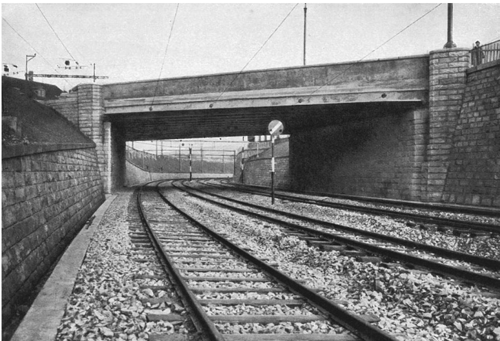
«Seebahneinschnitt», Strassenüberführung Badenerstrasse (261AUSEEBAHN00005) nach Fertigstellung, Ansicht von SO, aus: Denkschrift anlässlich der Eröffnung am 1. März 1927, Abb. 49, 01.01.1927 (Bild Nr. D101369_60).
