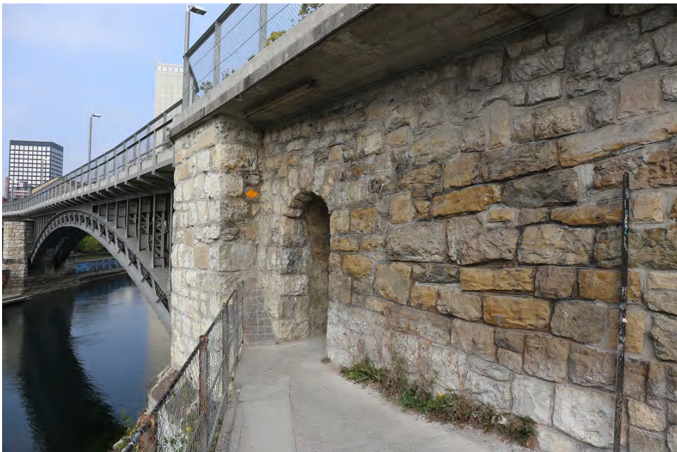
Lettenviadukt, Lettendamm mit Personendurchlass Kloster-Fahr-Weg (261WPDAMM00003), Ansicht von SO, 20.10.2018 (Bild Nr. D101138_58).
