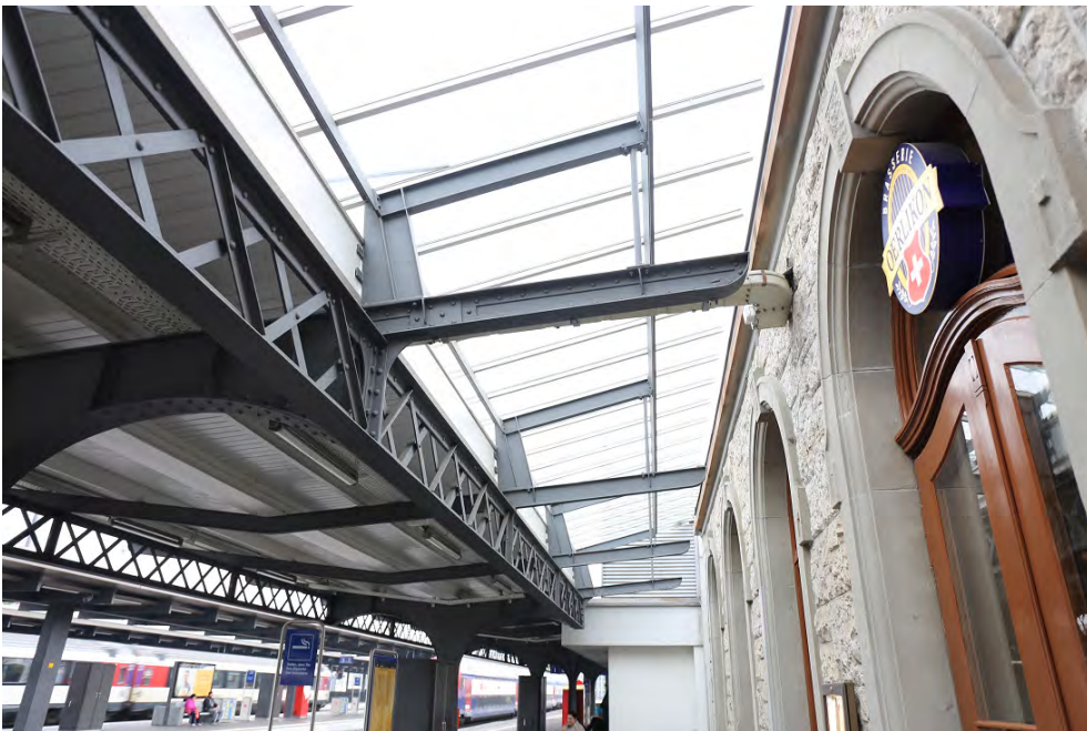
Bahnhof Zürich Oerlikon, Perrondach (261OEPERRON00068), Untersicht mit nachträglich erhöhtem Glasband und Teil der Nordwestfassade des Aufnahmegebäudes (261OE00068), 26.10.2018 (Bild Nr. D101353_45).
