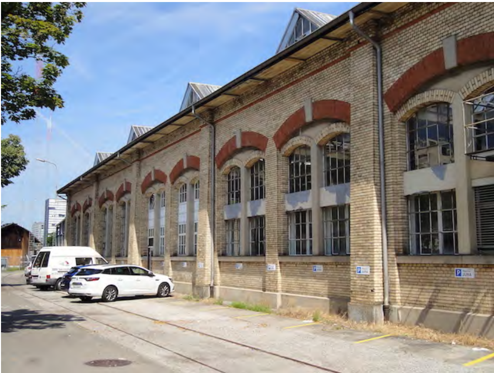
Hauptwerkstätten, Wagenwerkstätte II (261AU00082), Südwestfassade, 17.07.2019 (Bild Nr. D101369_03).
