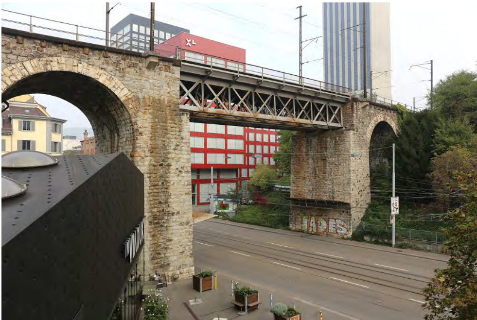
Wipkinger Viadukt, Hausteinbögen mit Strassenunterführungen (261AUVIADUKT00001), Strassenunterführung Limmatstrasse, Ansicht von S, 20.10.2018 (Bild Nr. D101353_73).
