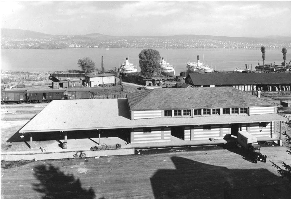
Bahnhof Zürich Wollishofen, Güterschuppen (261WO01100), strassenseitige Ansicht von W, Bild: Baugeschichtliches Archiv Zürich, Sign. DMP_061245, 01.01.1928 (Bild Nr. D101139_15).
