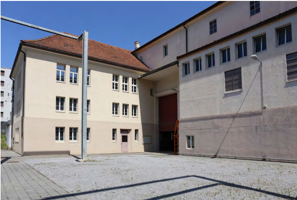
Unterwerk Seebach, Dienstgebäude, Ansicht von SO, 01.07.2019 (Bild Nr. D101382_04).
