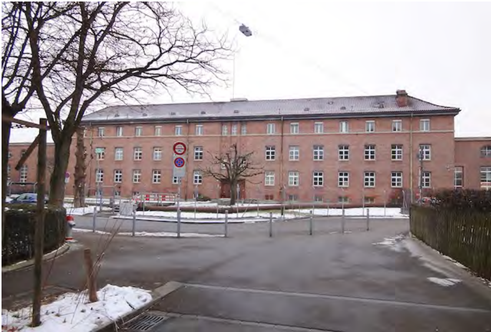
«Lokomotivremise G», Dienstgebäude (261AUDIENST04007), Ansicht von NO, 26.01.2017 (Bild Nr. D101395_06).
