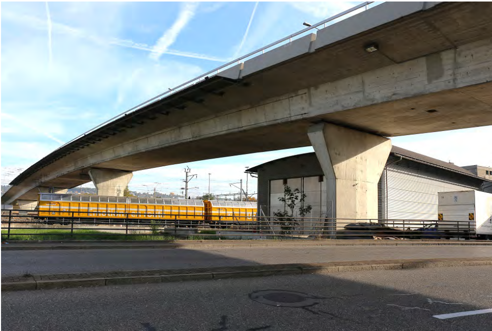
«Schnellgut-Stammbahnhof» Zürich Altstetten, Hermetschloobrücke (261ALBRUECKE00001) mit oktogonalen Hammerkopfpfeilern und gekerbter Brüstung, Ansicht von SW, 25.10.2018 (Bild Nr. D101353_25).
