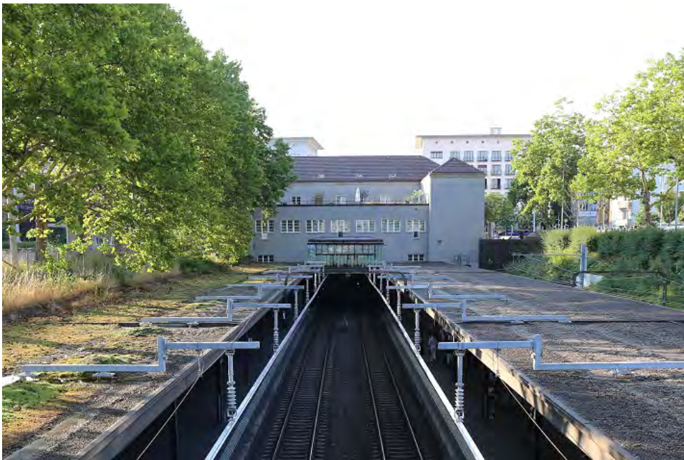
Bahnhof Zürich Wiedikon, Aufnahmegebäude (261WD02412), Ansicht von NW, 17.10.2018, (Bild Nr. D101354_78).
