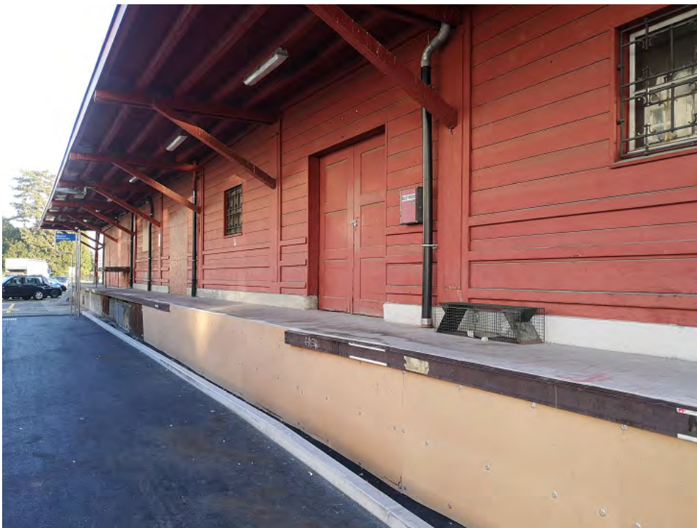
Bahnhof Zürich Wollishofen, Güterschuppen (261WO01100), Ansicht von SW, 16.01.2019 (Bild Nr. D101139_07).
