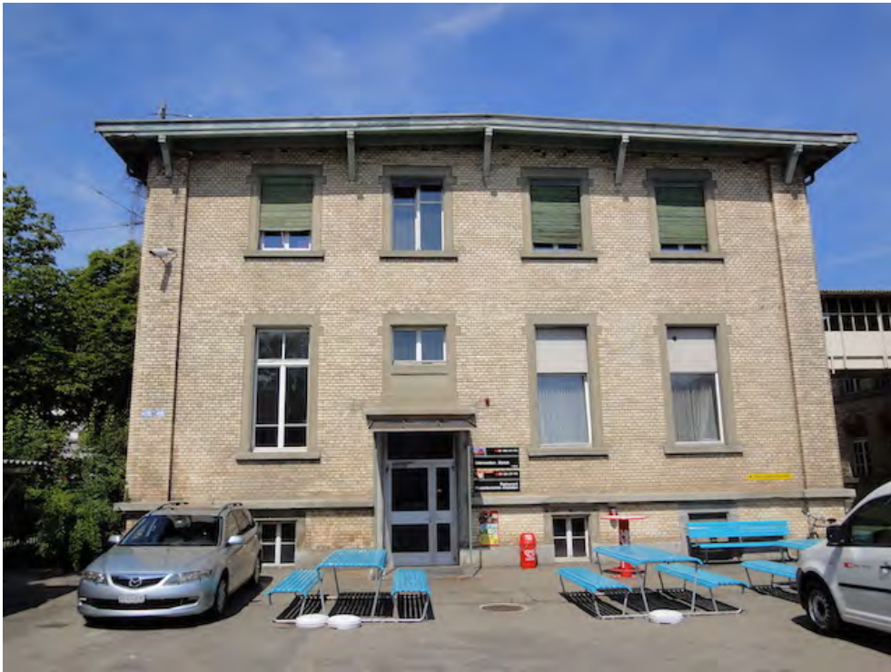
Hauptwerkstätten, Speisehaus (261AU03290), Südostfassade, 17.07.2019 (Bild Nr. D101369_24).
