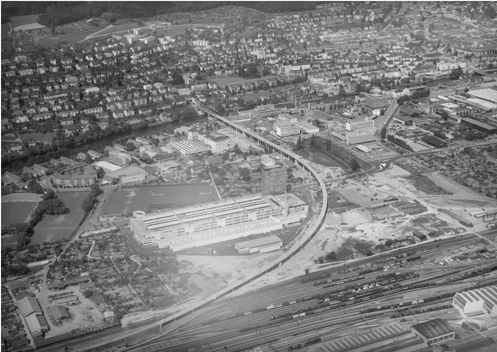
Hardturmviadukt, westlicher Schenkel (2611QHARDTU00001), Flugaufnahme von SW mit fertiggestelltem westlichem und noch fehlendem östlichem Schenkel, Bild: ETH-Bildarchiv, Sign. LBS_H1-027520, 15.5.1968 (Bild Nr. D101138_78).
