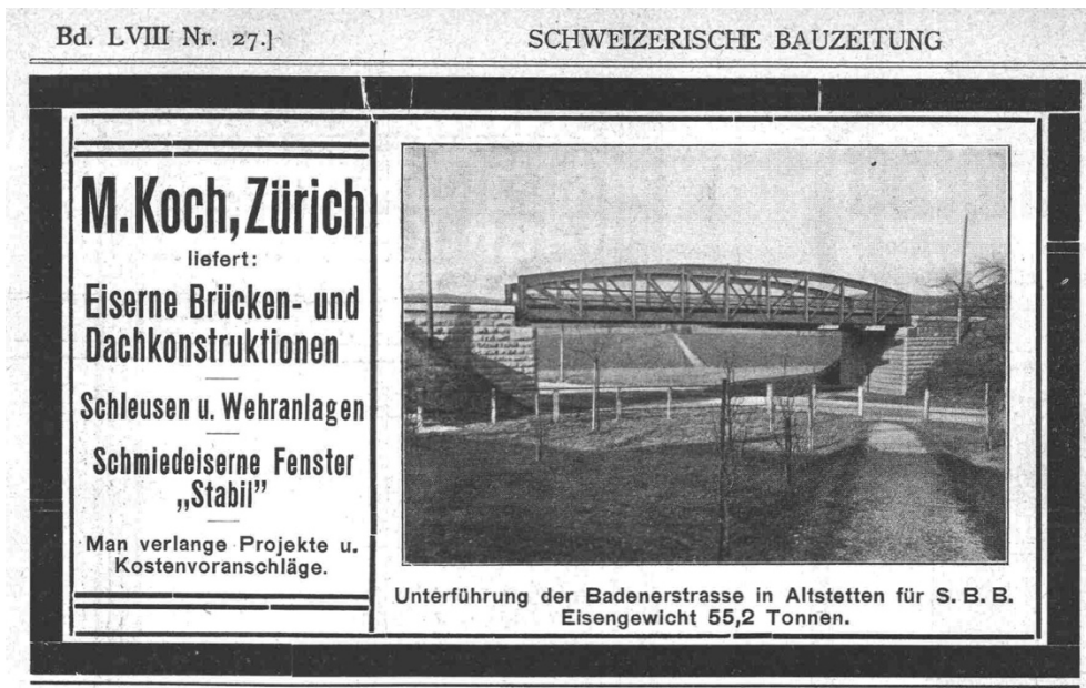
Strassenunterführung Badenerstrasse, Vorgängerbau, Ansicht von S, Situation von 1904 bis 1958 mit einem Halbparabelträger der M. Koch AG, in: Schweizerische Bauzeitung, 1911, o. S., 01.01.1911 (Bild Nr. D101354_45).
