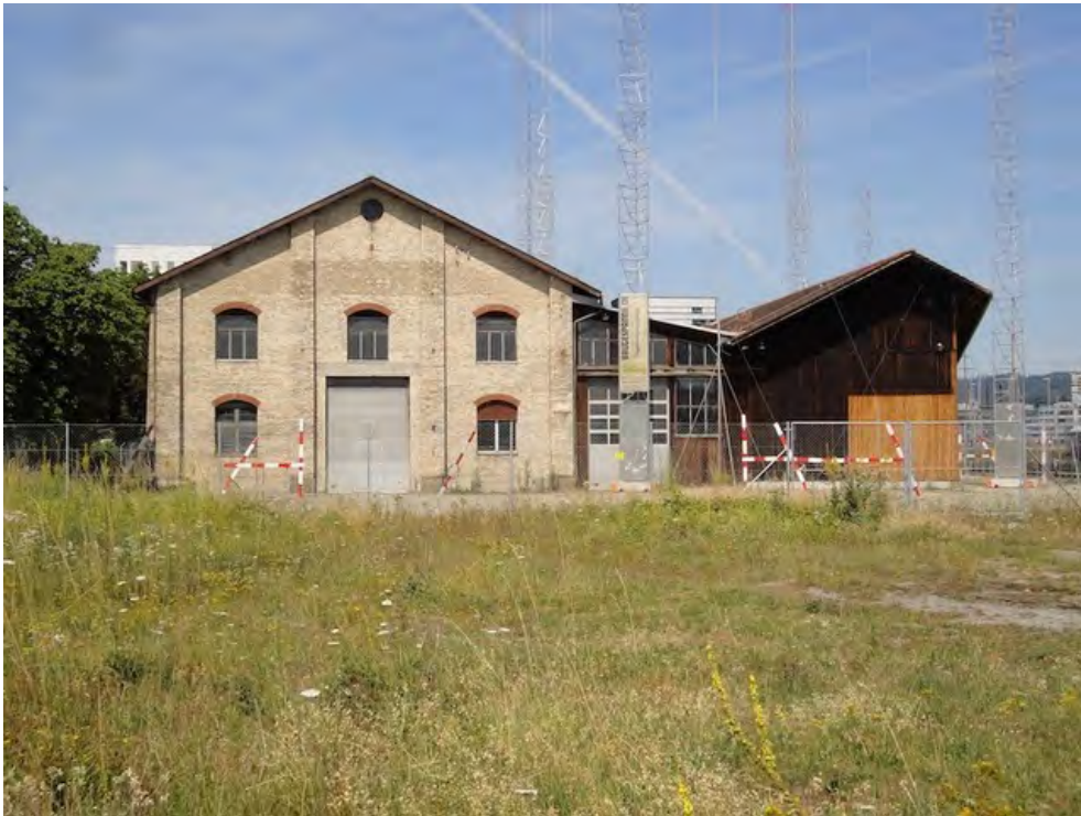
Hauptwerkstätten, Holzlagerschuppen, sogenannte «Elsässer Halle» (261AU01231) mit Sichtbacksteinfassade (links), Verbindungsbau und sogenannter «Baumann'scher Schuppen» (rechts), Ansicht von SO, 17.07.2019 (Bild Nr. D101369_08).
