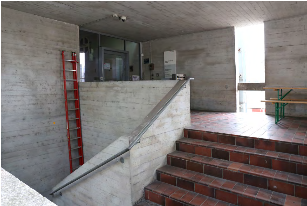
Stellwerke, Zentralstellwerk (261AU00932), Entrée mit Abgang zur Personenunterführung unter dem ehem. «Flügelbahnhof» hindurch nach SW, 15.12.2018 (Bild Nr. D101139_33).
