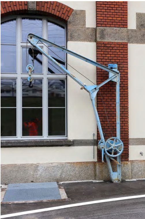
«Depot F», Schwenkhebekran Ost (261AUKRAN02834-1), 15.12.2018 (Bild Nr. D101139_61).
