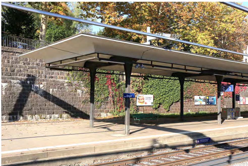
Bahnhof Zürich Enge, Perrondach 2 (261ENPERRON01270-2), Ansicht von SO, 18.10.2018 (Bild Nr. D101354_10).
