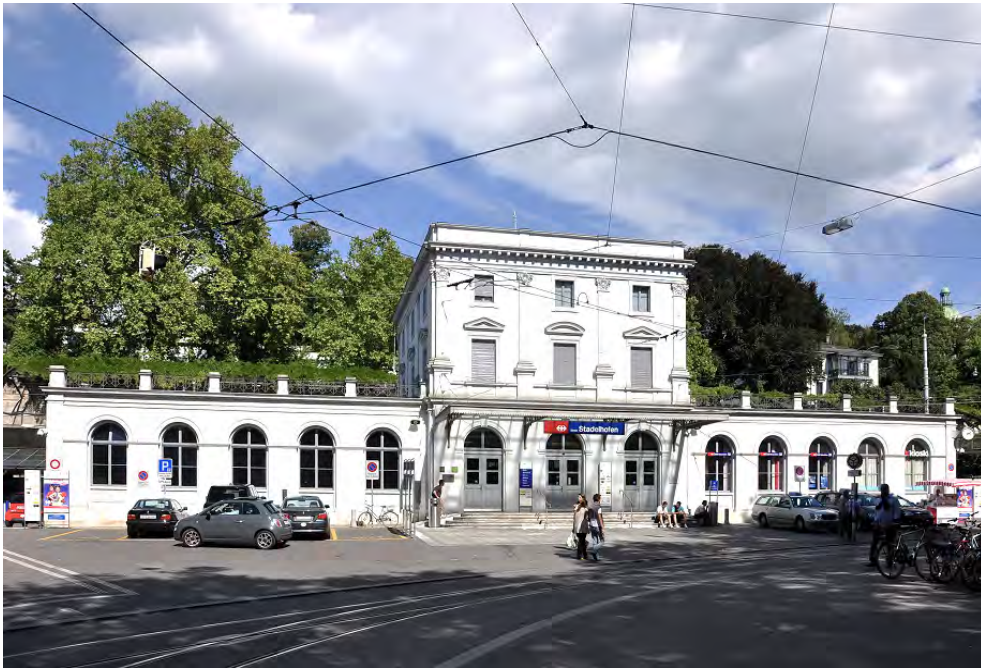
Bahnhof Zürich Stadelhofen, Aufnahmegebäude (261AA01031), Ansicht von SW, Wikimedia Commons, Bild: Wikimedia Commons, Roland_zh, 05.09.2010 (Bild Nr. D101354_82).
