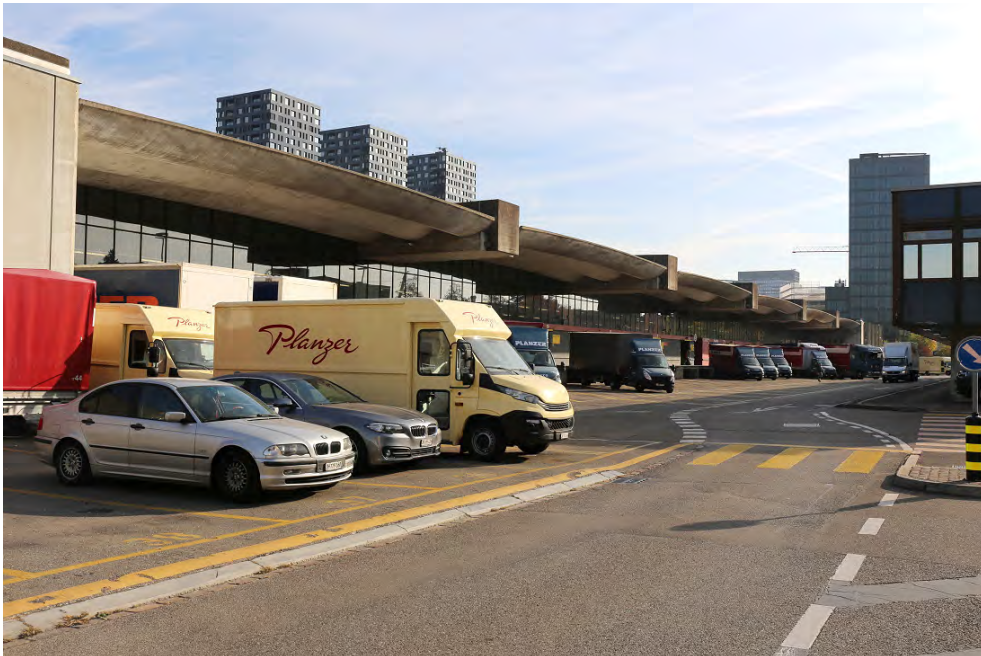
«Schnellgut-Stammbahnhof» Zürich Altstetten, «Schnellguthalle» (261AL00125), Lastwagenladerampe, Ansicht von SW, 25.10.2018 (Bild Nr. D101353_05).
