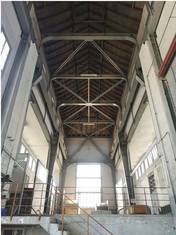
Unterwerk Seebach, Dienstgebäude, Halle gegen O mit Gleis zum Transformatorenfeld und dreischiffigem Ostteil für die Umformermaschine, 01.07.2019 (Bild Nr. D101382_09).
