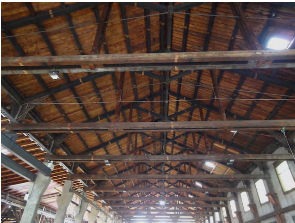
Hauptwerkstätten, Holzlagerschuppen, sogenannte «Elsässer Halle» (261AU01231), Dachstuhl von 1860, 17.07.2019 (Bild Nr. D101369_09).
