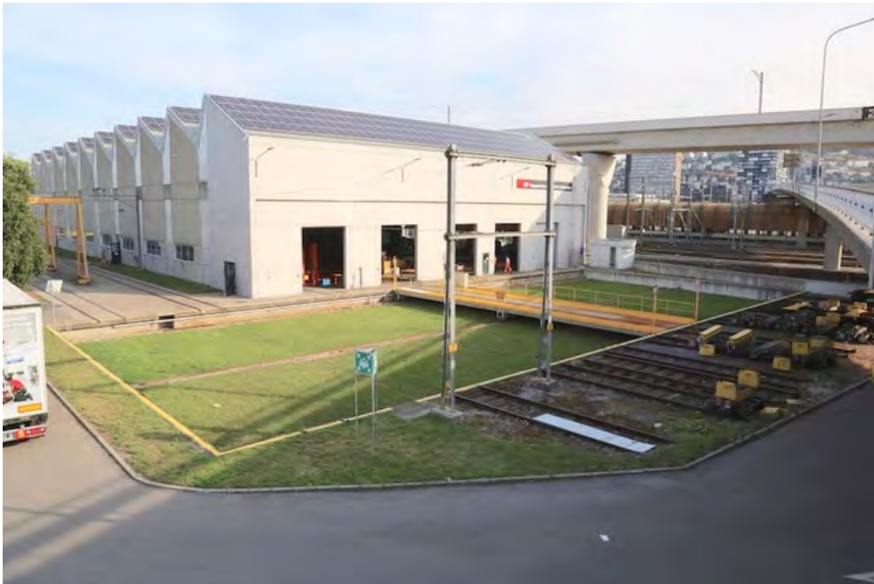
Hauptwerkstätten, Triebwagenhalle (261AU00878), davor die Schiebebühne Ost (261AUSCHIEBE00003), Ansicht von S, 17.07.2019 (Bild Nr. D101369_06).
