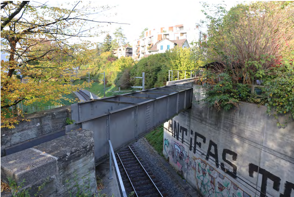
Überführung Nebelbach, Ansicht von S, 18.10.2018 (Bild Nr. D101139_23).
