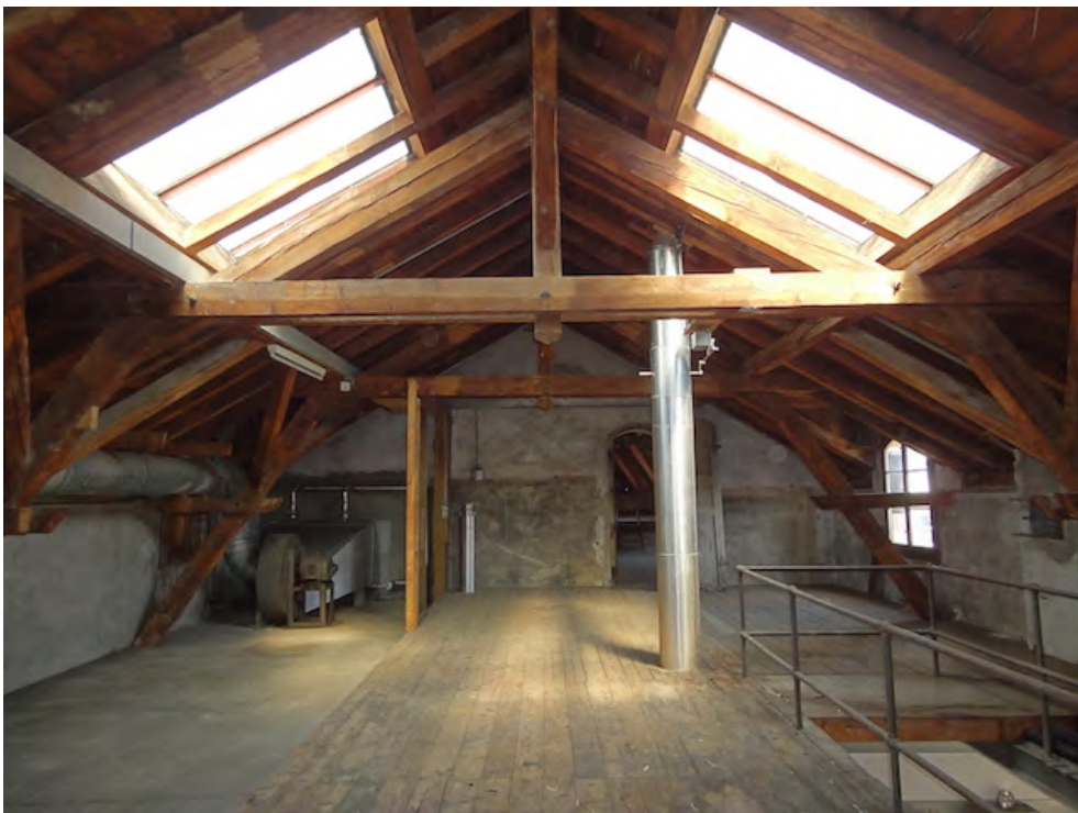
Hauptwerkstätten, Holzrocknerei (261AU03368), Lagerraum im OG, 17.07.2019 (Bild Nr. D101369_32).
