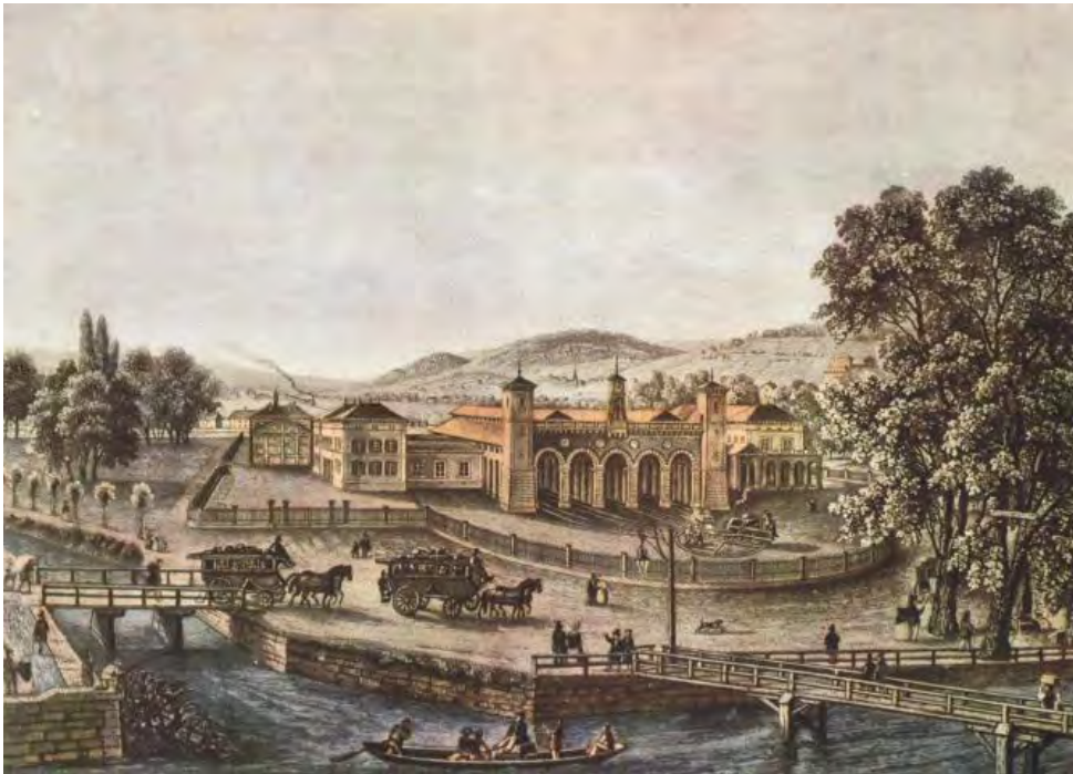
Hauptbahnhof, erster Bahnhof der Schweizerischen Nordostbahn-Gesellschaft, Ansicht von SO, Bild: Baugeschichtliches Archiv Zürich, Sign. DMP_005770, 01.01.1847 (Bild Nr. D101382_98).
