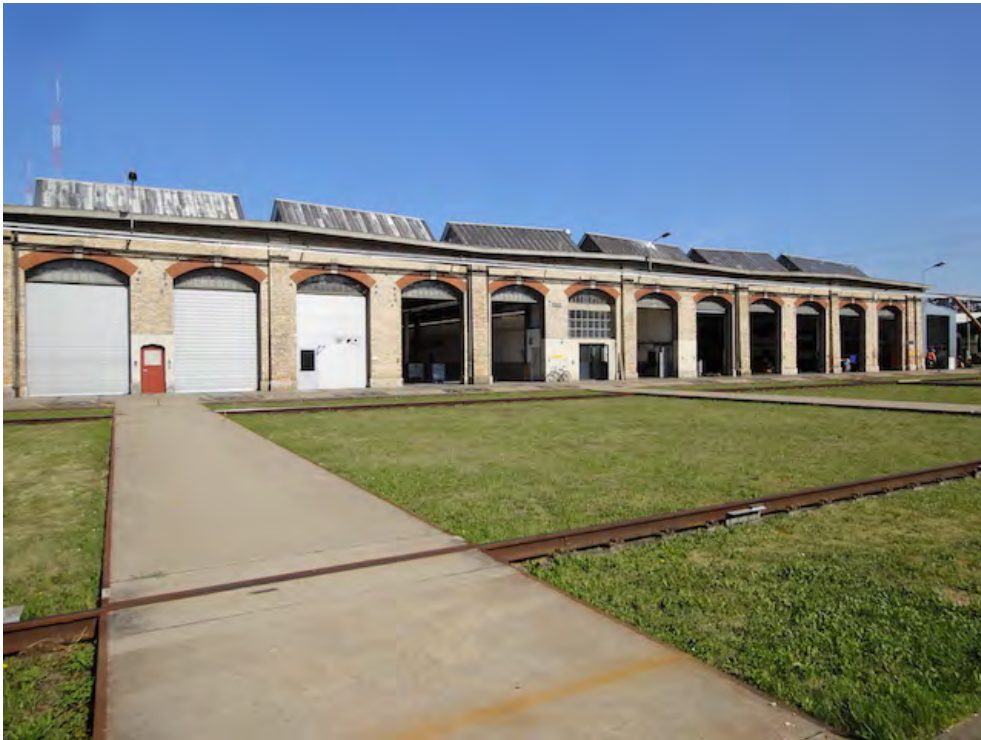
Hauptwerkstätten, Wagenwerkstätte II (261AU00082), Südostfassade, davor die Schiebebühne West (261AUSCHIEBE00001), 17.07.2019 (Bild Nr. D101369_04).
