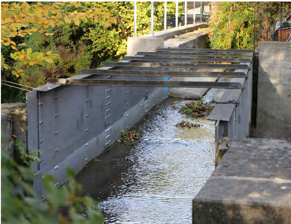
Überführung Nebelbach, Ansicht von SW, 18.10.2018 (Bild Nr. D101139_24).
