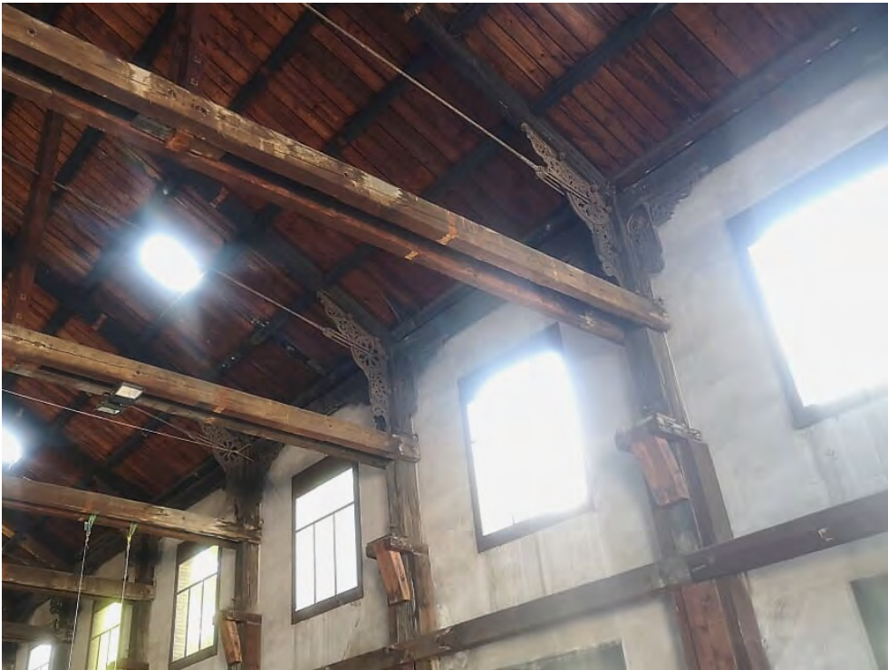
Hauptwerkstätten, Holzlagerschuppen, sogenannte «Elsässer Halle» (261AU01231), Dachstuhl von 1860 (Detail), 17.07.2019 (Bild Nr. D101369_44).
