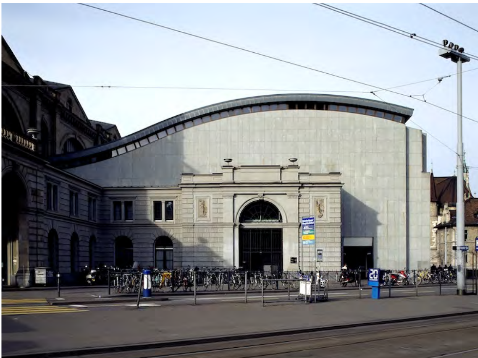
Hauptbahnhof, Bahnhofgebäude, Bahnhofhalle und Erweiterungsbau (261AA01592), Nordosttrakt, Südostfassade mit wiederaufgebauter Südostfassade des Posthofs von 1897–1902, Bild: Baugeschichtliches Archiv Zürich, Sign. BAZ_003033, 01.01.2005 (Bild Nr. D101382_82).
