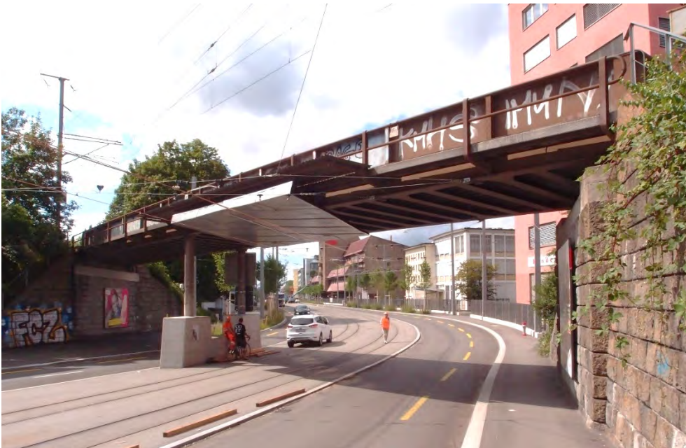
Strassenunterführung Badenerstrasse, Ansicht von SO, 10.08.2019 (Bild Nr. D101354_42).
