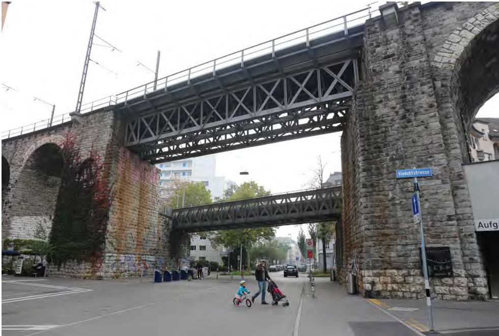
Wipkinger Viadukt, Hausteinbögen mit Strassenunterführungen (261AUVIADUKT00001), Strassenunterführung Heinrichstrasse, Ansicht von W, 20.10.2018 (Bild Nr. D101353_72).
