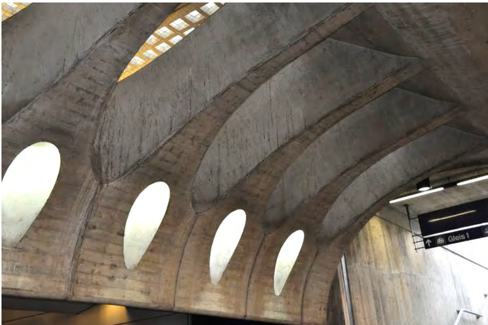
Bahnhof Zürich Stadelhofen, Perronanlage (261AA01033), Ladenpassage, 25.06.2019 (Bild Nr. D101356_71).
