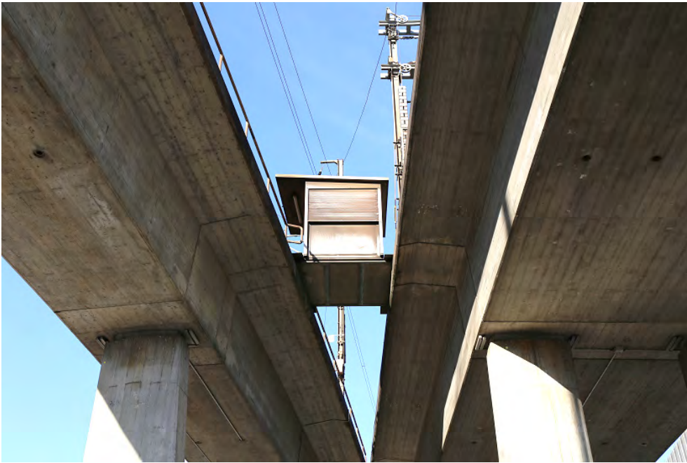
Hardturmviadukt, Stellwerkkabine (2611QSTELLW00001), Ansicht von S, 25.10.2018 (Bild Nr. D101138_80).
