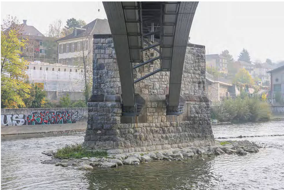
Lettenviadukt, Limmatbrücke (261IQBRUECKE00008), Pfeiler in der Limmat und Untersicht auf die Fachwerkbögen, Ansicht von W, 20.10.2018 (Bild Nr. D101138_66).
