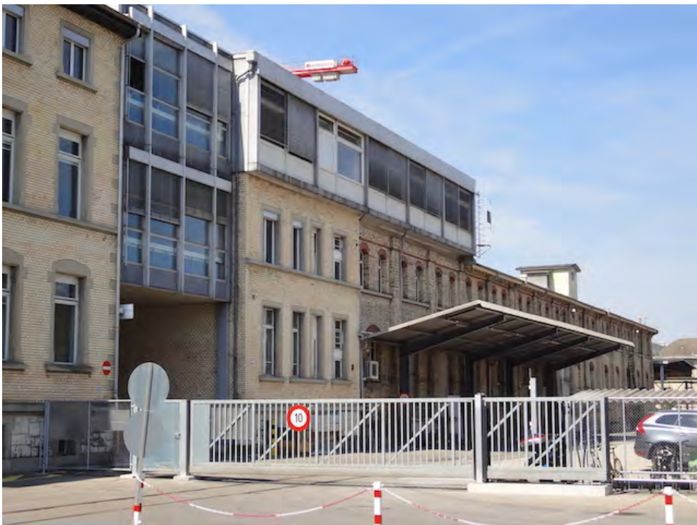
Hauptwerkstätten, Magazingebäude und Portierhaus (261AU03103), Ansicht von O, 17.07.2019 (Bild Nr. D101369_12).
