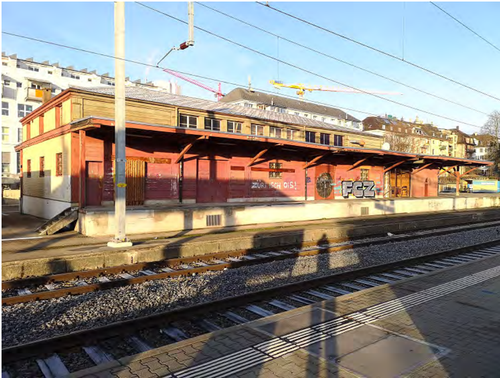
Bahnhof Zürich Wollishofen, Güterschuppen (261WO01100), Ansicht von SO, 16.01.2019 (Bild Nr. D101139_05).
