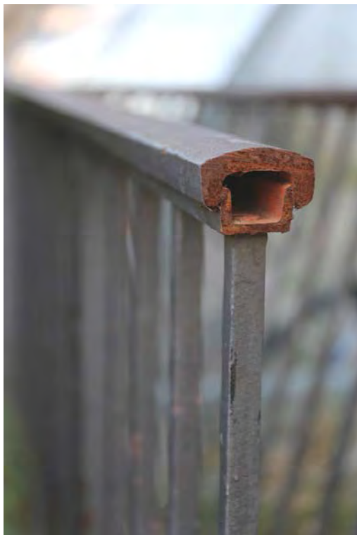
«Seebahneinschnitt», Trasse, Böschungen, Stützmauern und Staketengeländer (261AUSEEBAHN00001), aufgeschnittenes Staketengeländer (Detail) mit oberem und unterem U-Profil, 17.10.2018 (Bild Nr. D101369_65).
