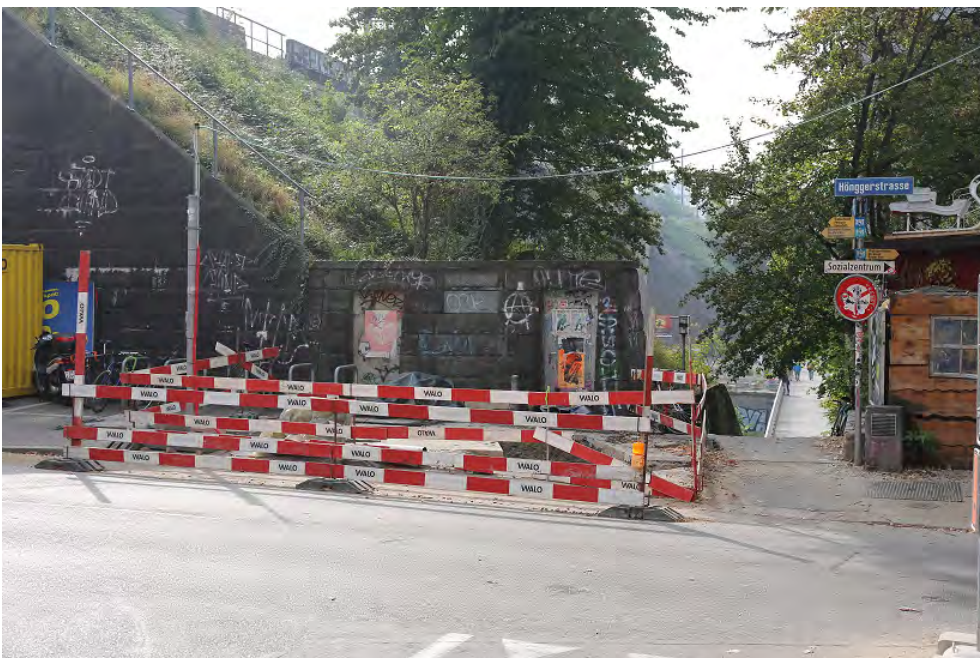
Wipkinger Viadukt, Erddamm Wasserwerkstrasse (261WPDAMM00001) und Pissoir (261WPPISSOIR00001), Ansicht von N, 20.10.2018 (Bild Nr. D101353_86).
