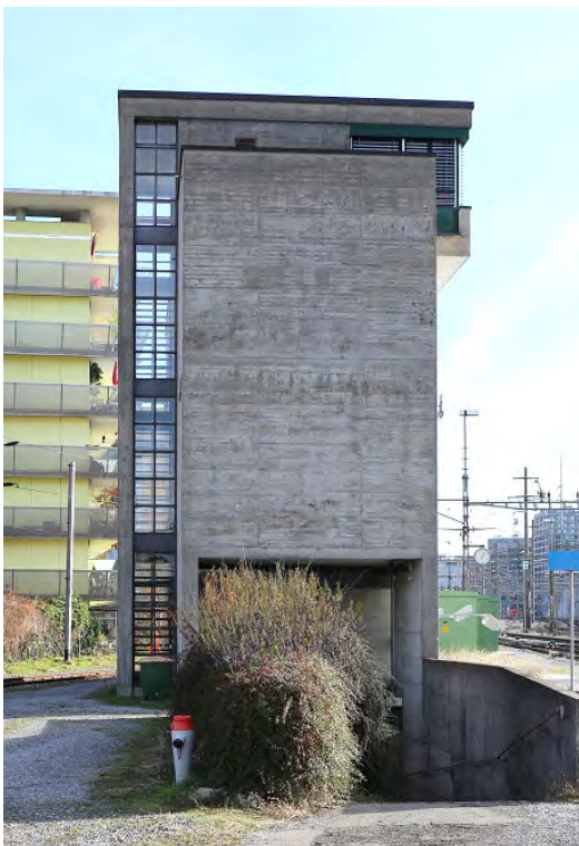
Stellwerke, Stellwerk Nord (261AU00933), Ansicht von NW, 16.01.2019 (Bild Nr. D101139_35).
