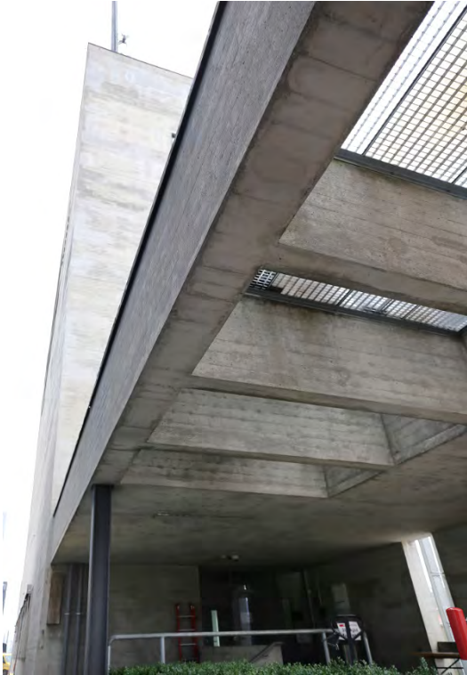
Stellwerke, Zentralstellwerk (261AU00932), Vordach im SO, 15.12.2018 (Bild Nr. D101139_32).
