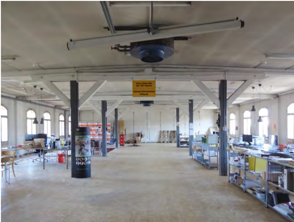
Hauptwerkstätten, Magazingebäude und Portierhaus (261AU03103), Magazingebäude, Lagerraum im OG, 17.07.2019 (Bild Nr. D101369_14).
