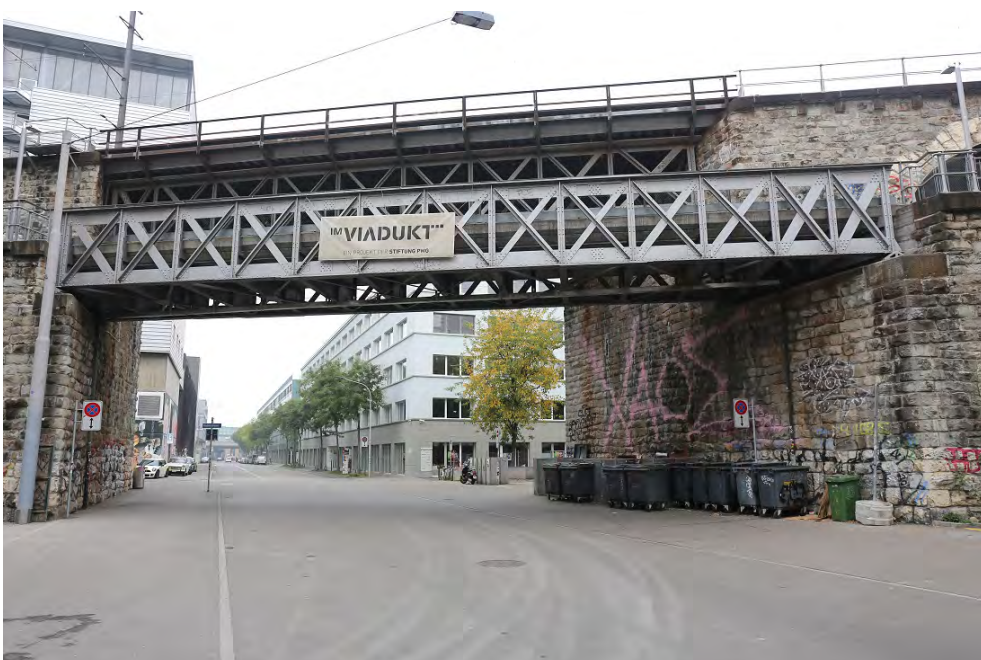
Lettenviadukt, Hausteinbögen und Strassenunterführungen (261AUVIADUKT00002), Strassenunterführung Josefstrasse, Ansicht von SO, 20.10.2018 (Bild Nr. D101138_50).
