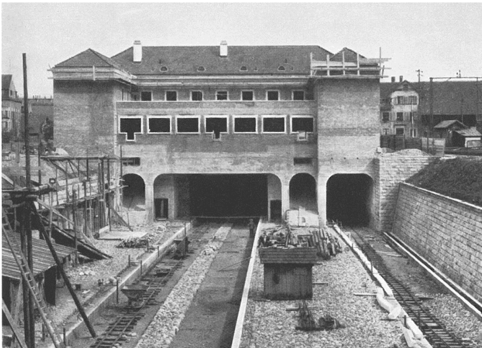
Bahnhof Zürich Wiedikon, Aufnahmegebäude (261WD02412) und Perronanlagen im Bau, Ansicht von NW, aus: Robert Grünhut und Martin Hürlimann, Der Umbau der linksufrigen Zürichseebahn im Gebiete der Stadt Zürich (Denkschrift anlässlich der Eröffnung am 1. März 1927), Abb. 41, 01.01.1927 (Bild Nr. D101354_72).
