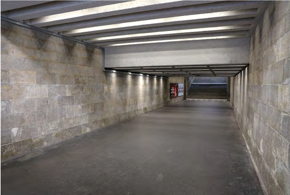
Bahnhof Zürich Enge, Personenunterführung Nord (261ENUNTERF01270-1), 18.10.2018 (Bild Nr. D101354_19).
