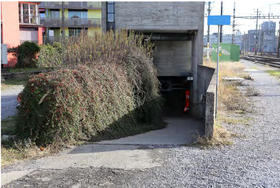
Stellwerke, Stellwerk Nord (261AU00933), Abgang zur Personenunterführung (261AUUNTERF00933), 16.01.2019 (Bild Nr. D101139_38).
