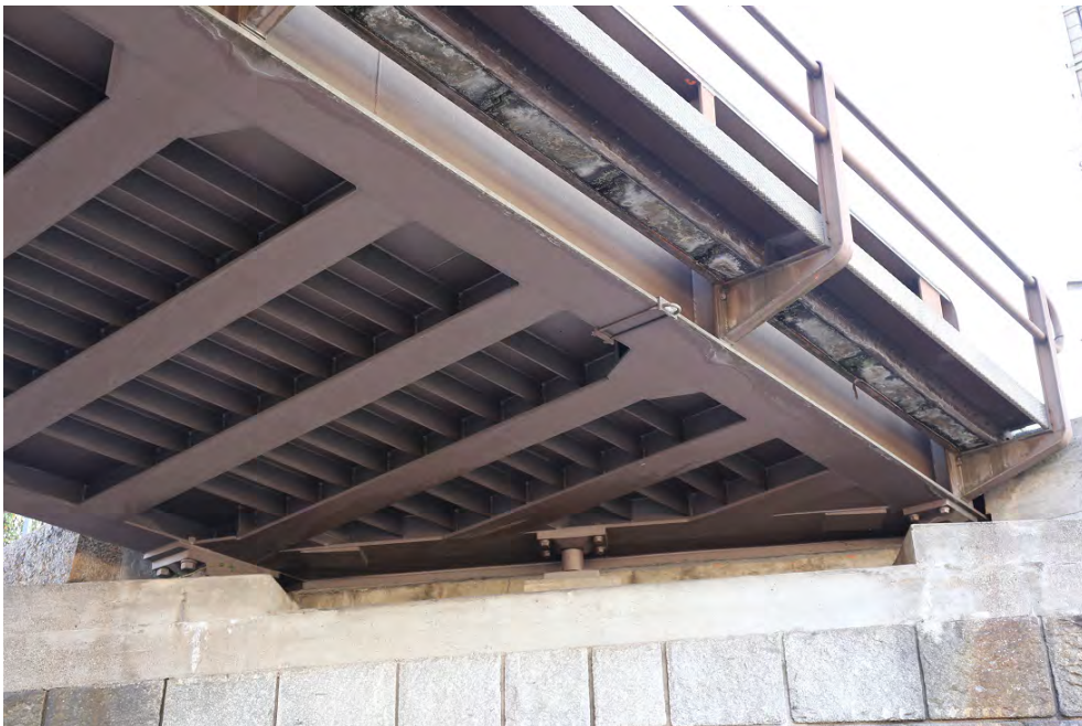
Strassenunterführung Badenerstrasse, östliches Widerlager mit den drei Lagern am östlichen Trägerende, 25.10.2018 (Bild Nr. D101354_43).
