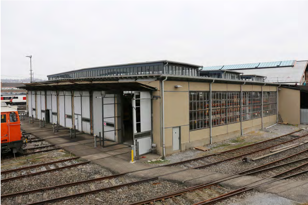
«Depot F», Hauptgebäude «Depot F» (261AU02834), nordwestlicher Anbau, Ansicht von SW, 15.12.2018 (Bild Nr. D101139_54).
