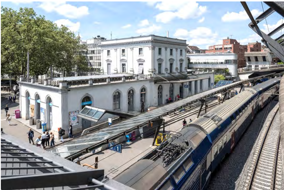
Bahnhof Zürich Stadelhofen, Aufnahmegebäude (261AA01031), Ansicht von O vom Fussgängersteg Falkenweg, Bild: Schweizerische Bundesbahnen SBB, www.sbb.ch/de/bahnhof-services/bahnhoefe/bahnhof-zuerich-stadelhofen.html , Stand 24.04.2019 (Bild Nr. D101354_83).
