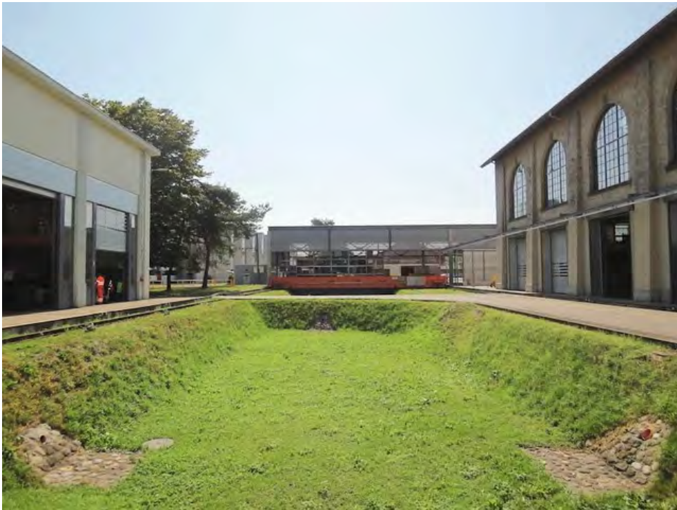
Hauptwerkstätten, Schiebebühne Lokomotivreparaturwerkstätte (261AU03200) zwischen den Montagehallen VIII, rechts (261AU03200) und IX (261AU03200), links, Ansicht von NW, 17.07.2019 (Bild Nr. D101369_36).
