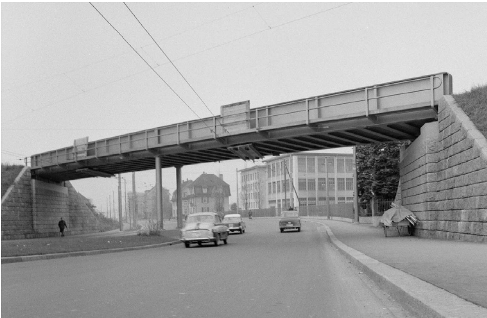
Strassenunterführung Badenerstrasse, Ansicht von SO, Bild: SBB Historic, 01.11.1958 (Bild Nr. D101354_48).
