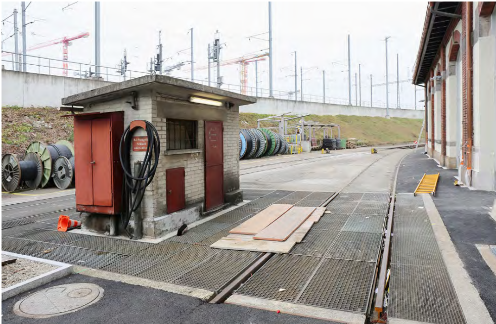
«Depot F», Waschanlage (261AUWASCH02834), Ansicht von O, 15.12.2018 (Bild Nr. D101139_65).
