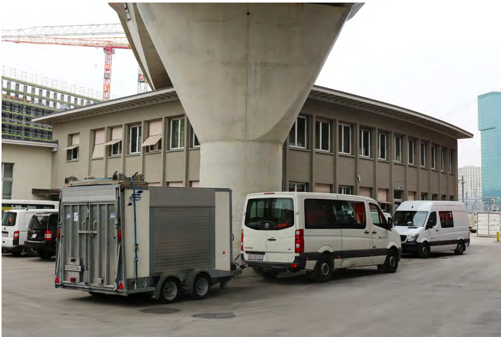
Dienstgebäude Fahrleitungsunterhalt, Hauptgebäude, Ansicht von SO, 15.12.2018 (Bild Nr. D101139_74).
