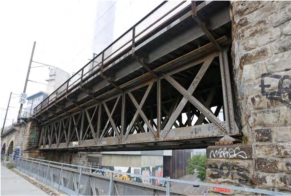
Wipkinger Viadukt, Hausteimbögen mit Strassenunterführungen (261AUVIADUKT00001), Strassenunterführung Josefstrasse, Ansicht vom Lettenviadukt (261AUVIADUKT00002 u. a.), 20.10.2018 (Bild Nr. D101353_70).
