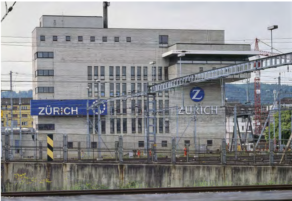
Stellwerke, Zentralstellwerk (261AU00932), Ansicht von NO, Foto: Heinrich Helfenstein, 05.06.2007 (Bild Nr. D101139_28).
