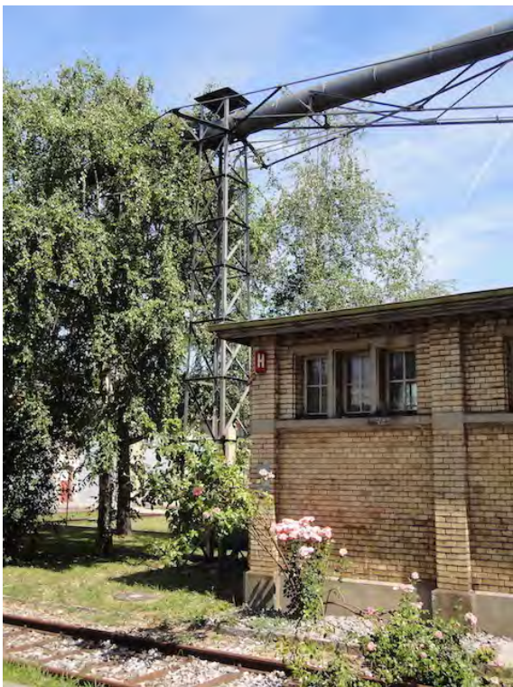
Hauptwerkstätten, Absauganlage (261AUABSAUG00001), Eisenfachwerkstütze, im Vordergrund das Abortgebäude (261AU03364), Ansicht von S, 17.07.2019 (Bild Nr. D101369_34).
