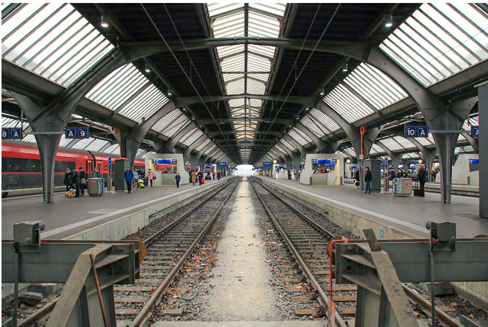
Hauptbahnhof, Querhalle und Perrondächer (261AAPERRON00001), Perrondächer, Bild: Wikimedia Commons, Hp.Baumeler, 30.12.2018 (Bild Nr. D101382_79).
