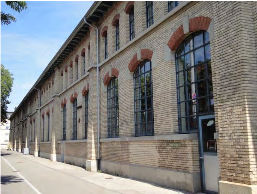
Hauptwerkstätten, Lokomotivreparaturwerkstätte (261AU03200), Südwestfassade, 17.07.2019 (Bild Nr. D101369_16).
