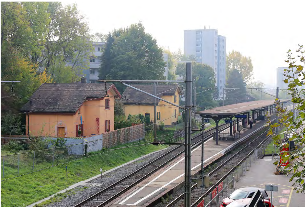
Bahnwärterhäuser, Ansicht von NW, 20.10.2018 (Bild Nr. D101353_33).
