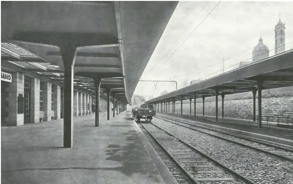
Bahnhof Zürich Enge, links Perrondach 1 (261ENPERRON01270-1), rechts Perrondach 2 (261ENPERRON01270-2), Ansicht von N, aus: Denkschrift zur Eröffnung am 01.03.1927, Zürich 1927, 01.01.1927 (Bild Nr. D101354_07).
