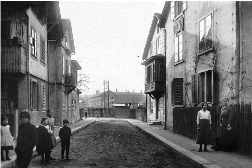
«Depot F», Neufrankengasse, Ansicht von SO, rechts hinter dem Haus mit dem Erker befindet sich der Abgang zur Personenunterführung Neufrankengasse (261AUUNTERF00934), im Hintergrund das Hauptgebäude «Depot F» (261AU02834), Bild: Baugeschichtliches Archiv Zürich, Sign. 938, 01.01.1900 (Bild Nr. D101139_59).
