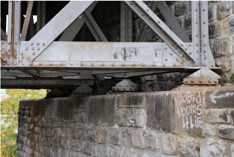
Wipkinger Viadukt, Hausteimbögen mit Strassenunterführungen (261AUVIADUKT00001), Strassenunterführung Josefstrasse, nördliches Auflager (Detail), Ansicht von O, 20.10.2018 (Bild Nr. D101353_71).
