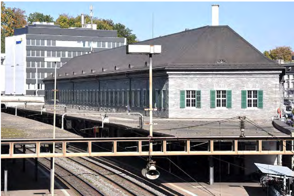
Bahnhof Zürich Enge, Aufnahmegebäude (261EN01270), Ansicht von S, Bild: Wikimedia Commons, Roland zh, 18.10.2011 (Bild Nr. D101354_02).
