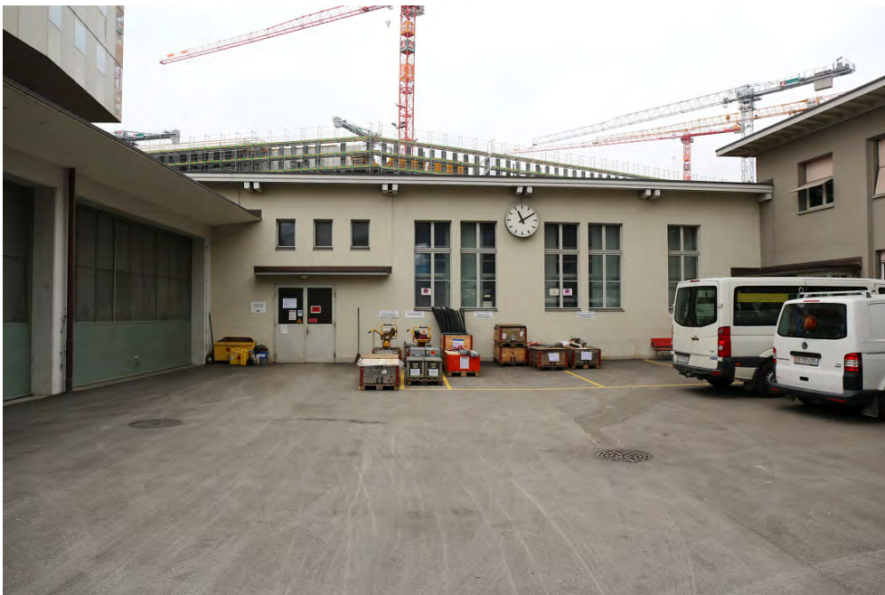
Dienstgebäude Fahrleitungsunterhalt, Innenhof vor der Werkstatt/Remise, Ansicht von O, 15.12.2018 (Bild Nr. D101139_75).
