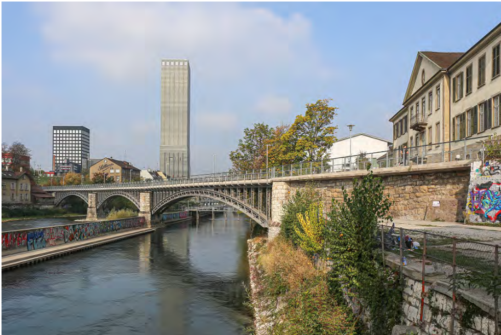
Lettenviadukt, links die Limmatbrücke (261IQBRUECKE00008), rechts der Lettendamm mit Personendurchlass Kloster-Fahr-Weg (261WPDAMM00003), Ansicht von SO, 20.10.2018 (Bild Nr. D101138_67).
