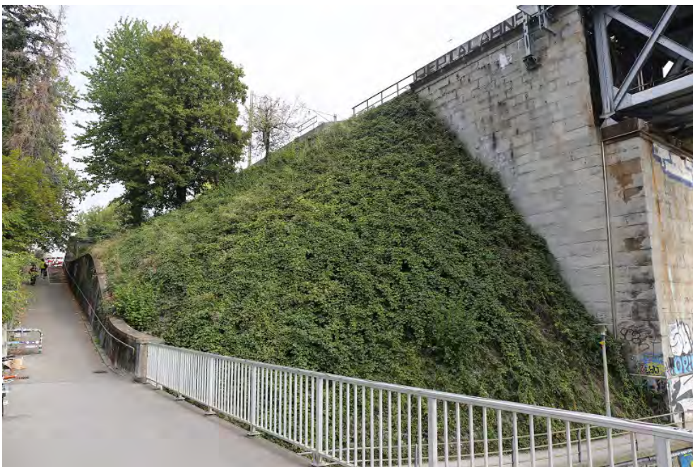
Wipkinger Viadukt, Erddamm Wasserwerkstrasse mit Pissoir (261WPDAMM00001), Ansicht von SW, 20.10.2018 (Bild Nr. D101353_80).
