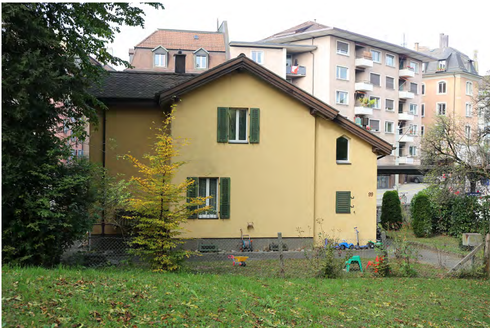
Bahnwärterhäuser, südliches Bahnwärterhaus (261WP00562), Ansicht von O, 20.10.2018 (Bild Nr. D101353_35).
