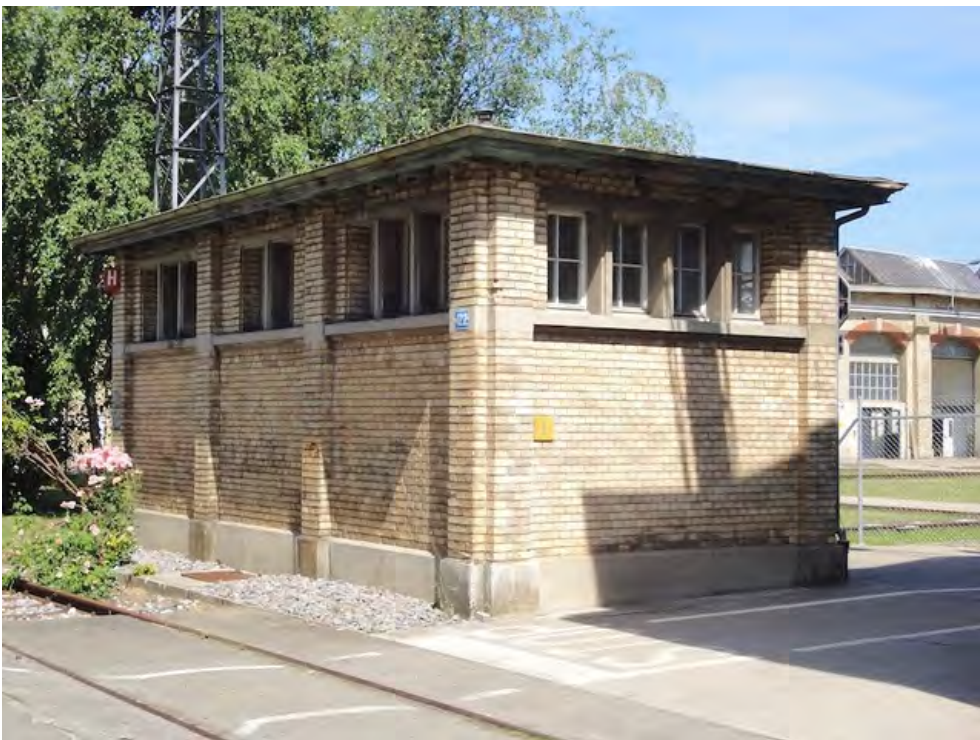
Hauptwerkstätten, Abortgebäude (261AU03364), Ansicht von S, 17.07.2019 (Bild Nr. D101369_30).
