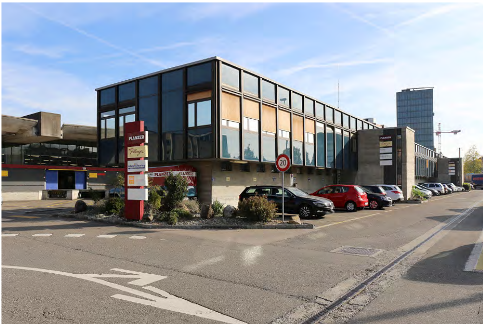
«Schnellgut-Stammbahnhof» Zürich Altstetten, Bürogebäude (261AL00002), Ansicht von SW, 25.10.2018 (Bild Nr. D101353_12).
