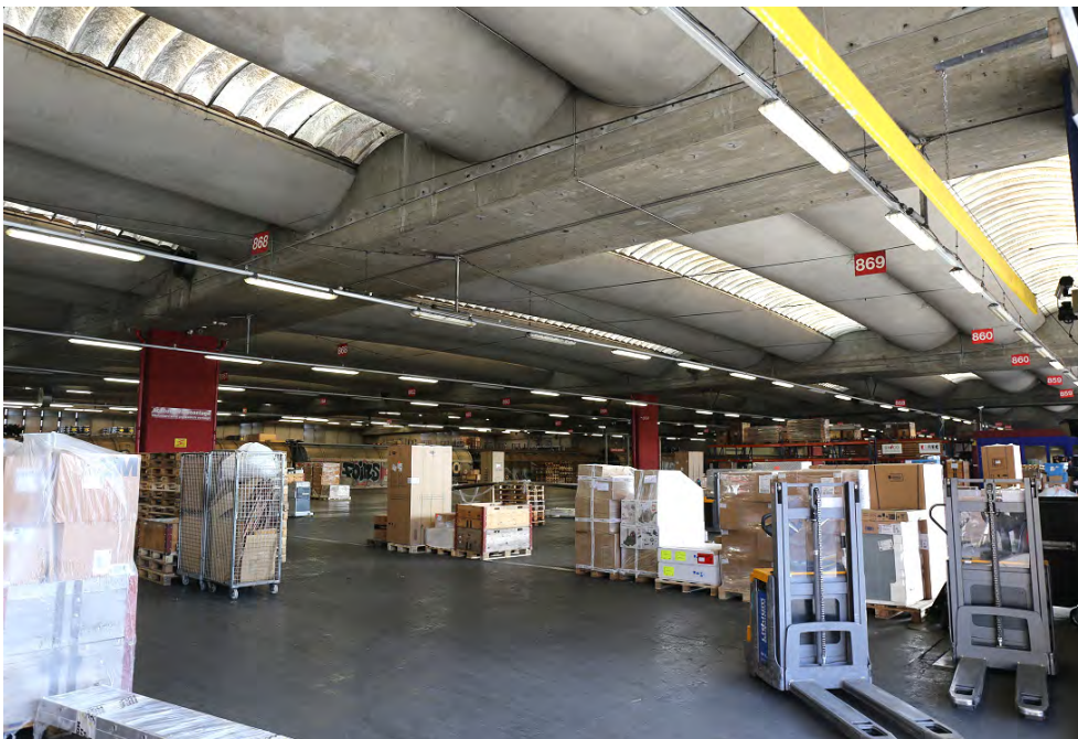
«Schnellgut-Stammbahnhof» Zürich Altstetten, «Schnellguthalle» (261AL00125), Innenansicht, 25.10.2018 (Bild Nr. D101353_06).
