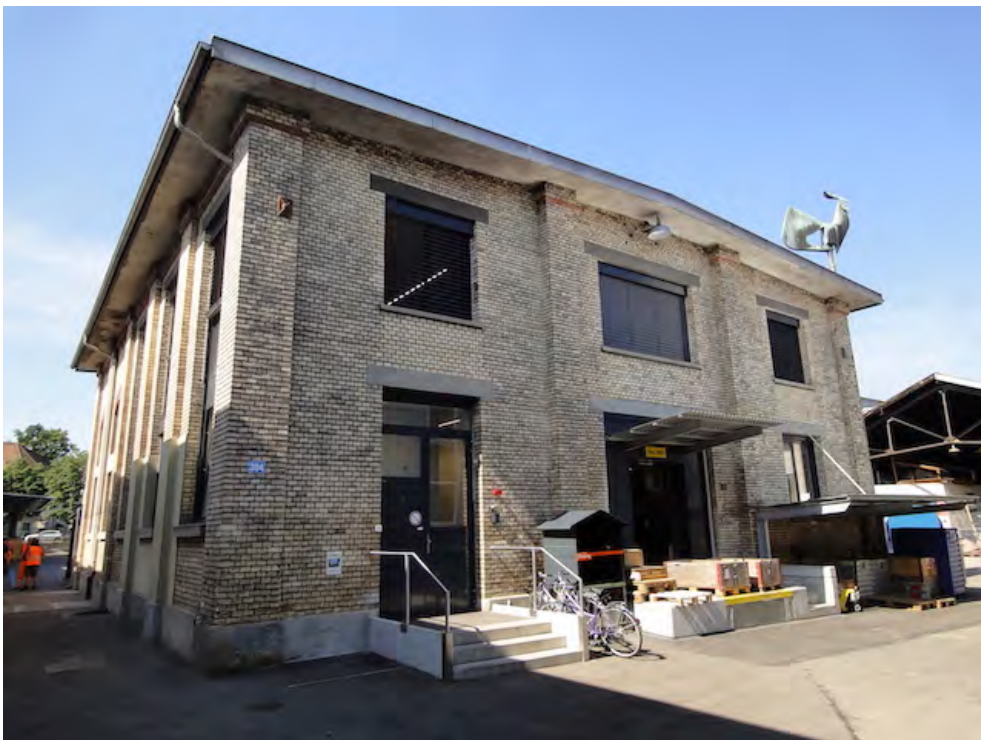
Hauptwerkstätten, Elektrische Zentrale (261AU03361), Ansicht von O, 17.07.2019 (Bild Nr. D101369_26).
