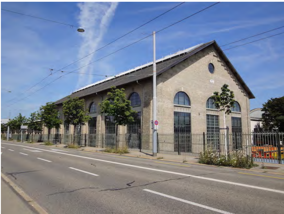
Hauptwerkstätten, Montagehalle VIII (261AU03200), Ansicht von S, davor die bauzeitlich erhaltene Einfriedung des Areals (261AUUMGEBU00001), 17.07.2019 (Bild Nr. D101369_18).
