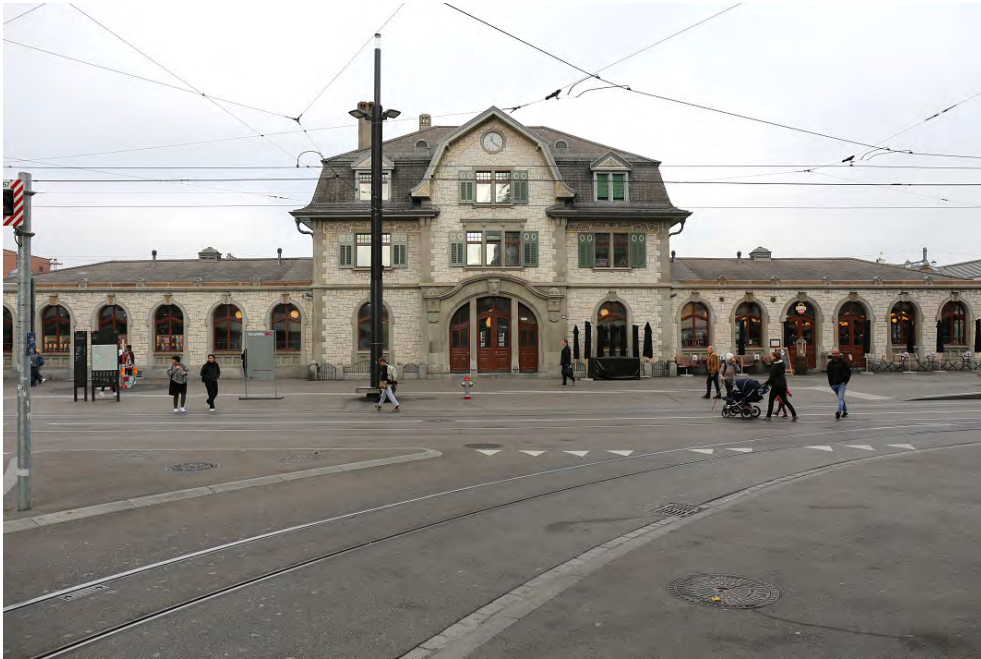
Bahnhof Zürich Oerlikon, Aufnahmegebäude (261OE00068), Ansicht von SO, 26.10.2018 (Bild Nr. D101353_42).
