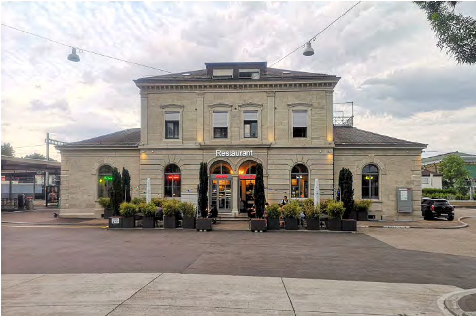
Bahnhof Zürich Wollishofen, Aufnahmegebäude (261WO00348), Ansicht von W, 12.07.2019 (Bild Nr. D101139_02).
