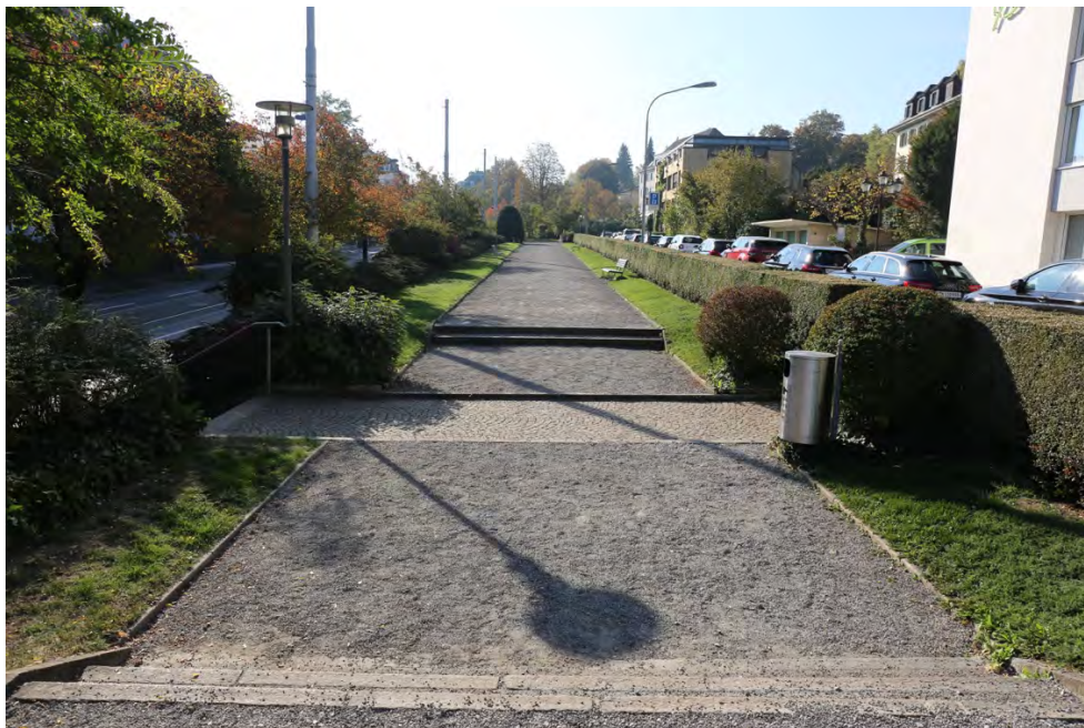
«Seebahneinschnitt», Engetunnel, Überdeckung mit Grünanlage (261ENTUNNEL00003), nördlicher Teil der als städt. Grünanlage gestalteten Tunnelüberdeckung, Ansicht von N, 18.10.2018 (Bild Nr. D101369_81).
