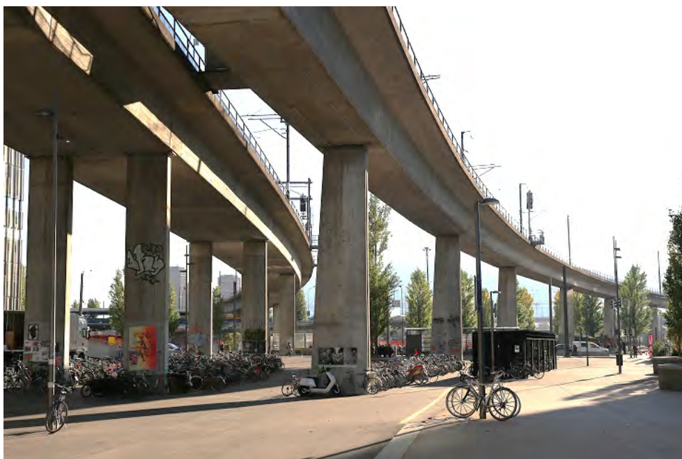
Hardturmviadukt, die beiden Schenkel über der Fussgängerzone bei der Tramhaltestelle Toni-Areal, beim zweispurigen östlichen Schenkel lagert der dreifache durchlaufende Hohlkastenträger auf Doppelstützen, beim einspurigen westlichen Schenkel sind die Stützen mit einseitigem Anzug ausgebildet, Ansicht von N, 25.10.2018 (Bild Nr. D101138_76).
