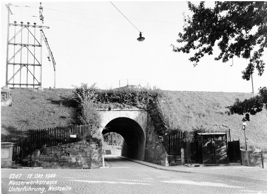
Wipkinger Viadukt, Strassenunterführung Wasserwerkstrasse vor dem Ausbau 1948, Ansicht von W, rechts der Vorgängerbau des Pissoirs (261WPPISOIR00001), Ansicht von W, Bild: Baugeschichtliches Archiv Zürich, Bild Nr. DMP_054643, 12.10.1944 (Bild Nr. D101353_84).
