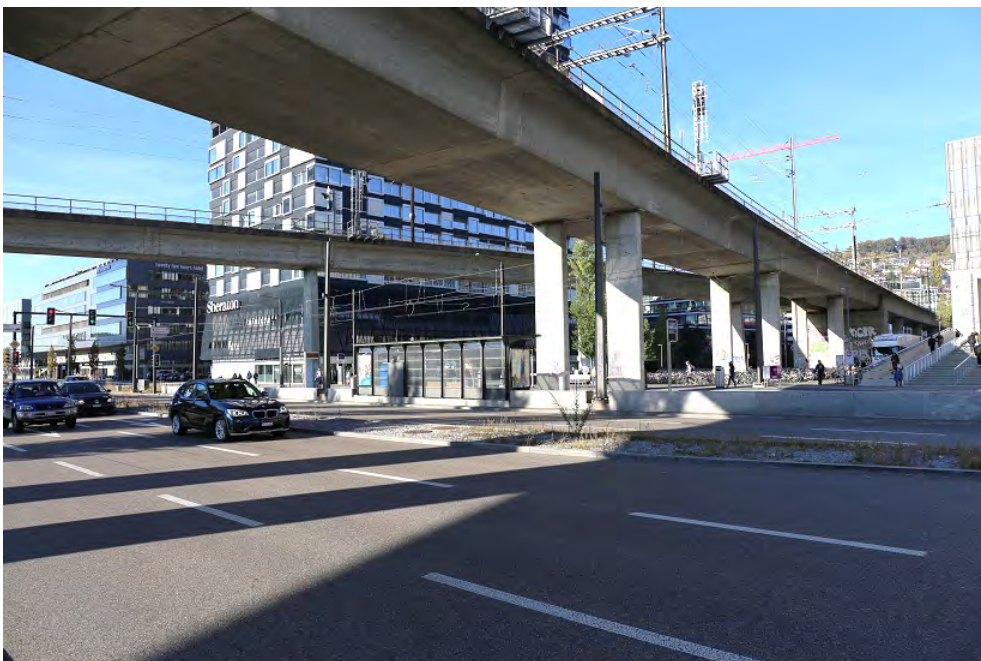
Hardturmviadukt, die beiden Schenkel über der Tramhaltestelle Toni-Areal, Ansicht von SO, 25.10.2018 (Bild Nr. D101138_74).
