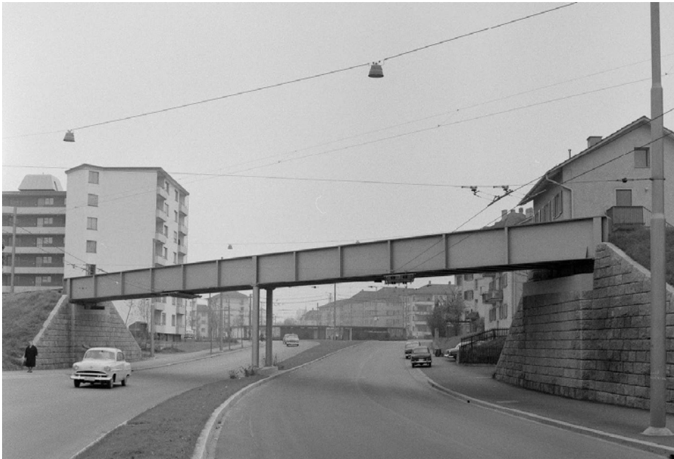
Strassenunterführung Badenerstrasse, Ansicht von W, Bild: SBB Historic, 01.11.1958 (Bild Nr. D101354_49).
