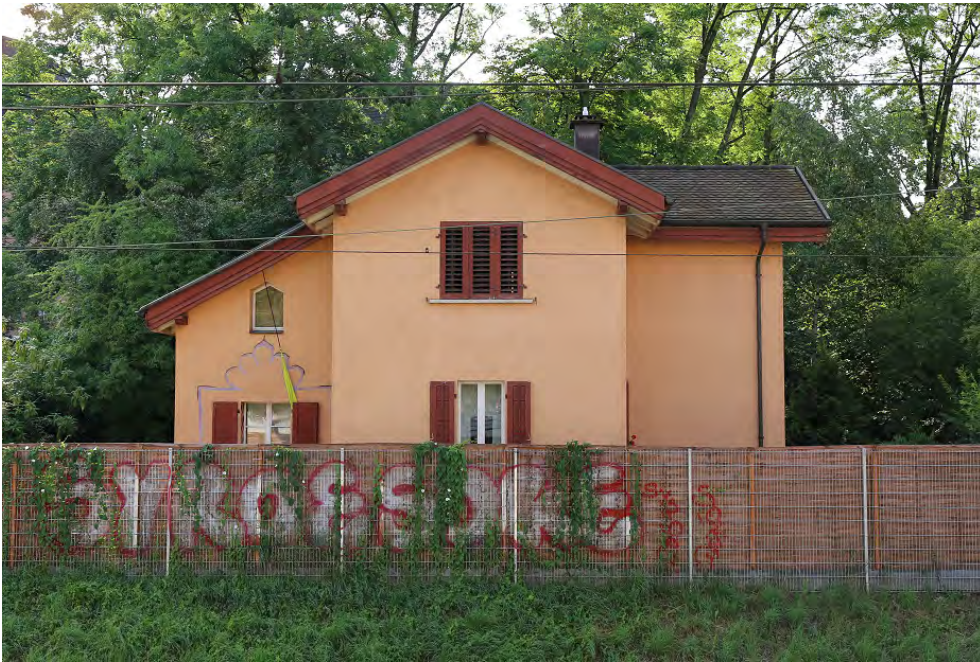
Bahnwärterhäuser, nördliches Bahnwärterhaus (261WP00547), Ansicht von W, 20.10.2018 (Bild Nr. D101353_38).
