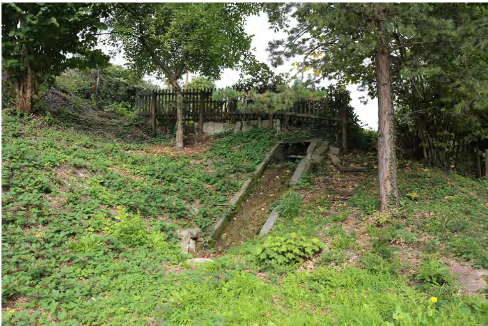
Wipkinger Viadukt, Erddamm Wipkingen mit Entwässerungsanlage (261WPDAMM00002), offener Entwässerungskanal, Ansicht von S, 20.10.2018 (Bild Nr. D101353_88).
