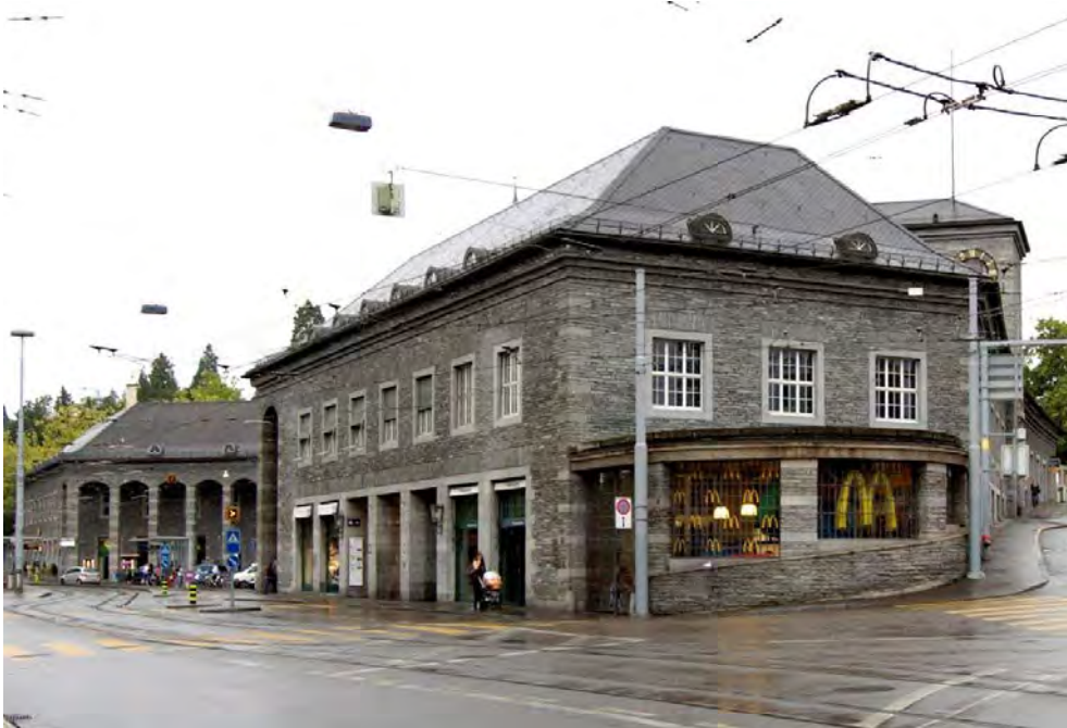
Bahnhof Zürich Enge, Aufnahmegebäude (261EN01270), Ansicht von NO, Bild: Wikimedia Commons, Felix Eggmann, 04.09.2011 (Bild Nr. D101354_04).
