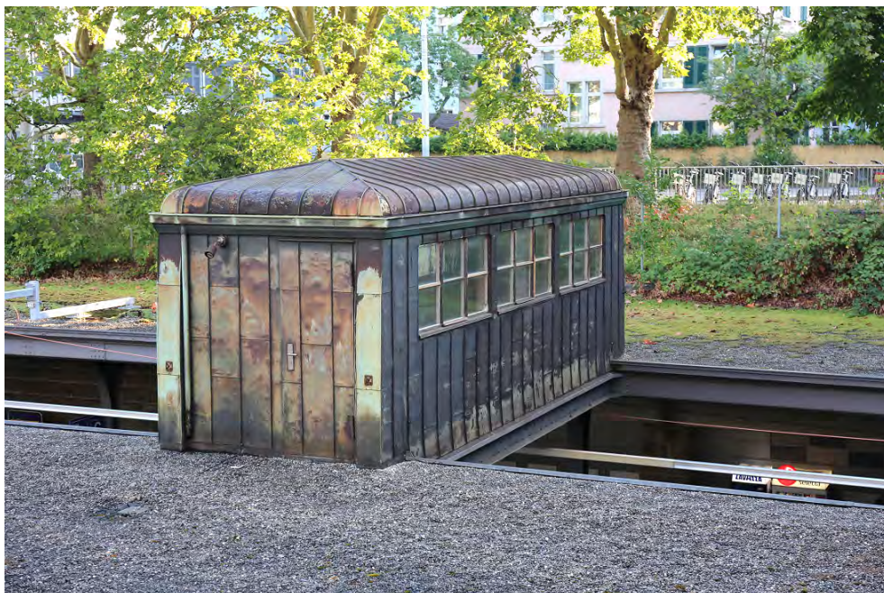
Bahnhof Zürich Wiedikon, Reiterstellwerk (261WDSTELLW00001), Ansicht von SW, 17.10.2018, (Bild Nr. D101354_79).
