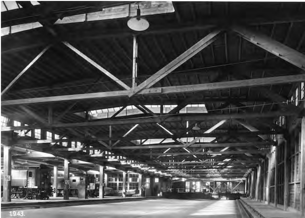
«Lokomotivremise G», Schiebebühnenhalle West (261AUSCHIEB04007-1), hölzernes Tragwerk in einer der Schiebebühnenhallen vor der Verstärkung, Bild: Baugeschichtliches Archiv Zürich, Sign. 18395, 01.01.1943 (Bild Nr. D101395_04).
