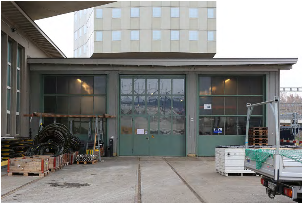
Dienstgebäude Fahrleitungsunterhalt, Werkstatt/Remise, Ansicht von N, 15.12.2018 (Bild Nr. D101139_78).
