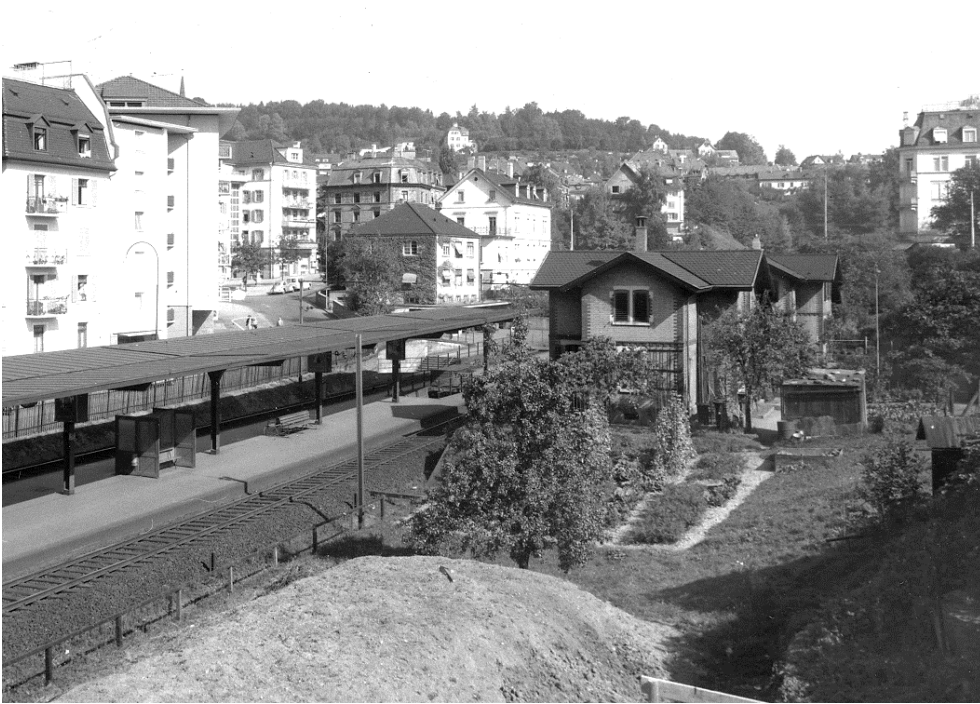
Bahnwärterhäuser, Ansicht von S mit Nutzgärten, Ansicht von S, Bild: Baugeschichtliches Archiv Zürich, Sign. DMP 054302, 01.01.1959 (Bild Nr. D101353_32).
