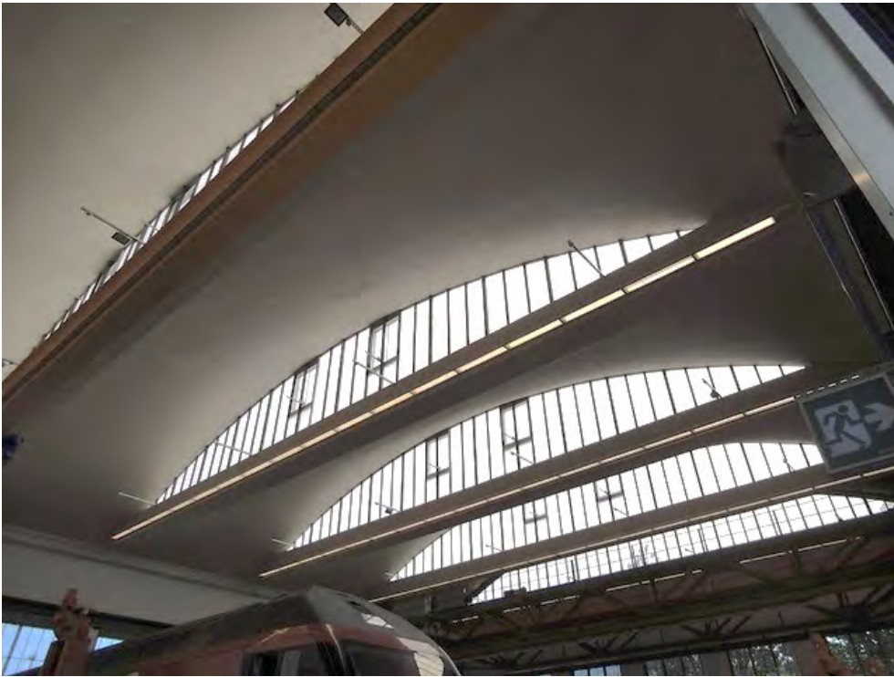
Hauptwerkstätten, Montagehalle IX (261AU03200), Decke aus Eisenbeton-Konoidschalen, 17.07.2019 (Bild Nr. D101369_21).
