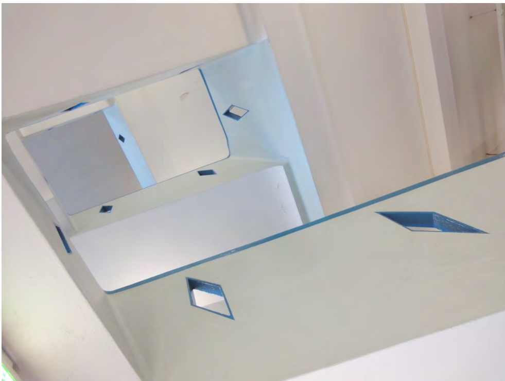
«Lokomotivremise G», Dienstgebäude (261AUDIENST04007), Treppenhaus, 21.12.2016 (Bild Nr. D101395_11).
