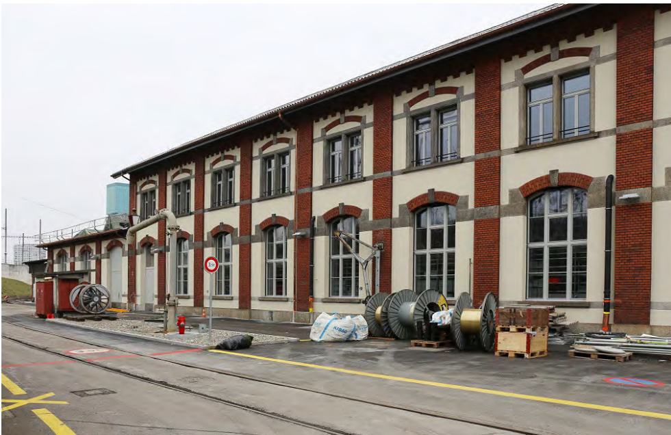
«Depot F», Hauptgebäude «Depot F» (261AU02834), westlicher Teil, Ansicht von S, 15.12.2018 (Bild Nr. D101139_53).
