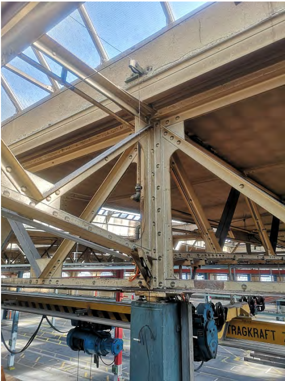
Hauptwerkstätten, Wagenwerkstätte I (261AU03362), Dachkonstruktion (Detail), 17.07.2019 (Bild Nr. D101369_29).
