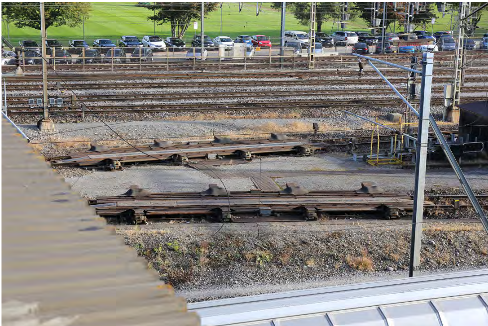
«Schnellgut-Stammbahnhof» Zürich Altstetten, die beiden Gleisbremsen am Ablaufberg westlich am Rangier- und Gleisbremsengebäude (261AL00081), Ansicht von SW, 25.10.2018 (Bild Nr. D101353_22).
