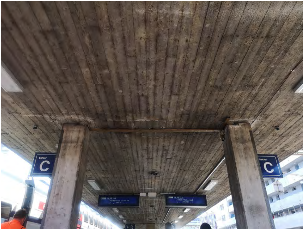
Bahnhof Zürich Altstetten, Perrondach 2 (261ALPERRON00700-2), 27.10.2018 (Bild Nr. D101139_91).
