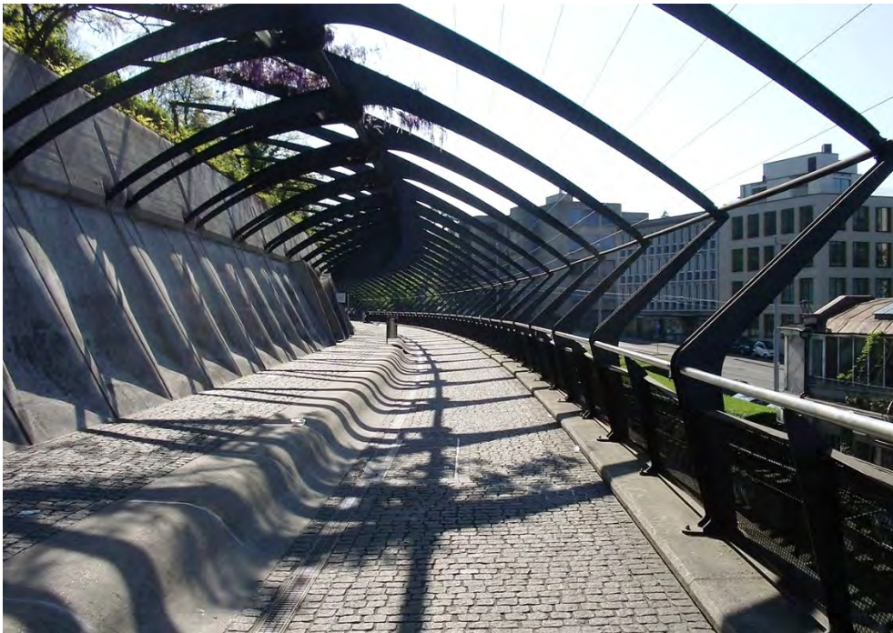
Bahnhof Zürich Stadelhofen, Perronanlage (261AA01033), Fussgängerpromenade, Ansicht von NW, Bild: Wikimedia Commons, Paebi, 15.04.2007 (Bild Nr. D101354_86).
