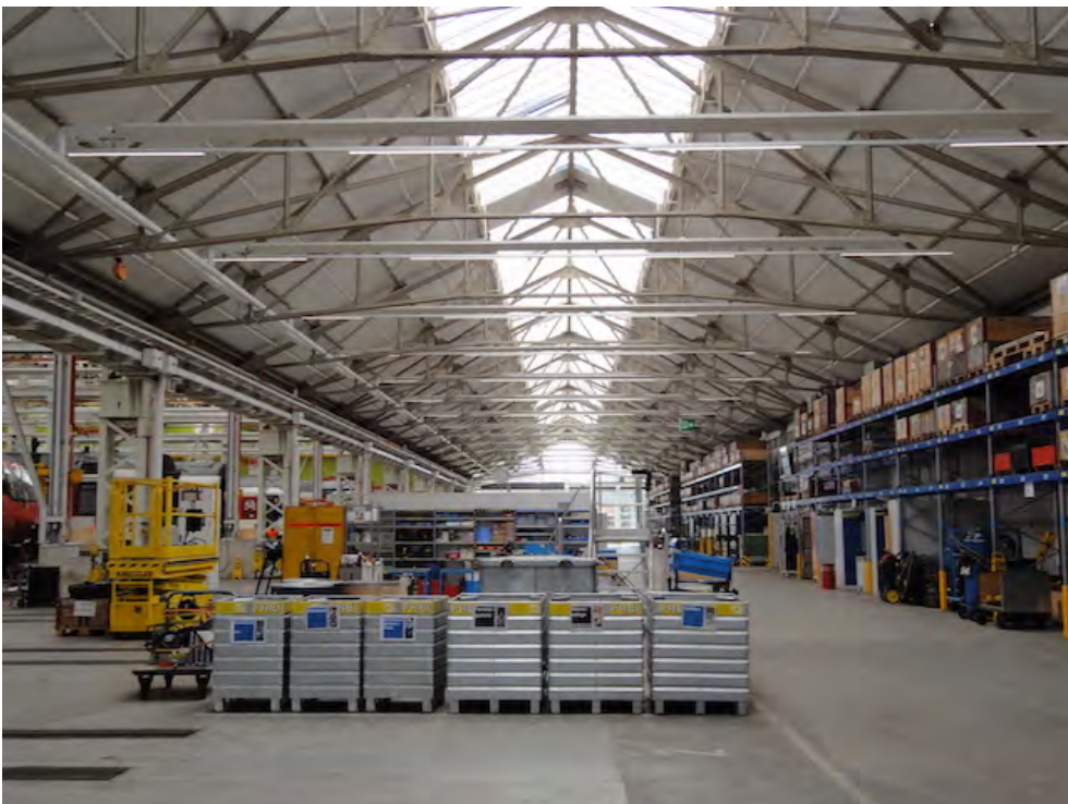
Hauptwerkstätten, Lokomotivreparaturwerkstätte (261AU03200), Inneres, ehem. Schiebepöhlenhalle, 17.07.2019 (Bild Nr. D101369_17).
