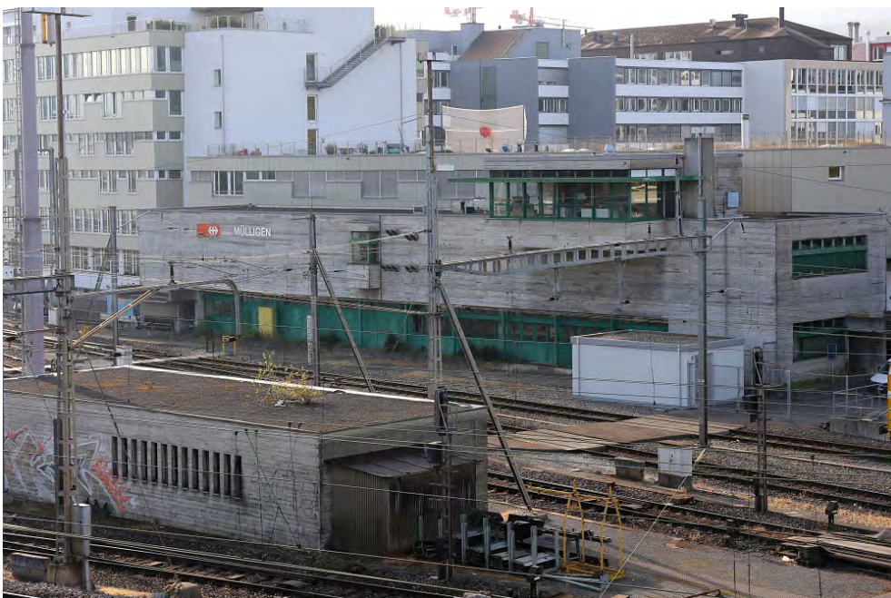
«Schnellgut-Stammbahnhof» Zürich Altstetten, Stellwerk (261AL00080), im Vordergrund das Rangier- und Gleisbremsengebäude (261AL00081), Ansicht von NW, 25.10.2018 (Bild Nr. D101353_20).
