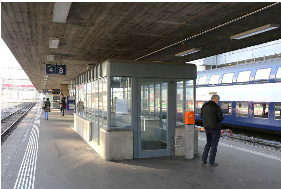
Bahnhof Zürich Altstetten, Perrondach 2 (261ALPERRON00700-2) mit einer nachträglich platzierten Wartehalle (Typenbau «Zangerhalle», heute abgebrochen), 27.10.2018 (Bild Nr. D101139_84).
