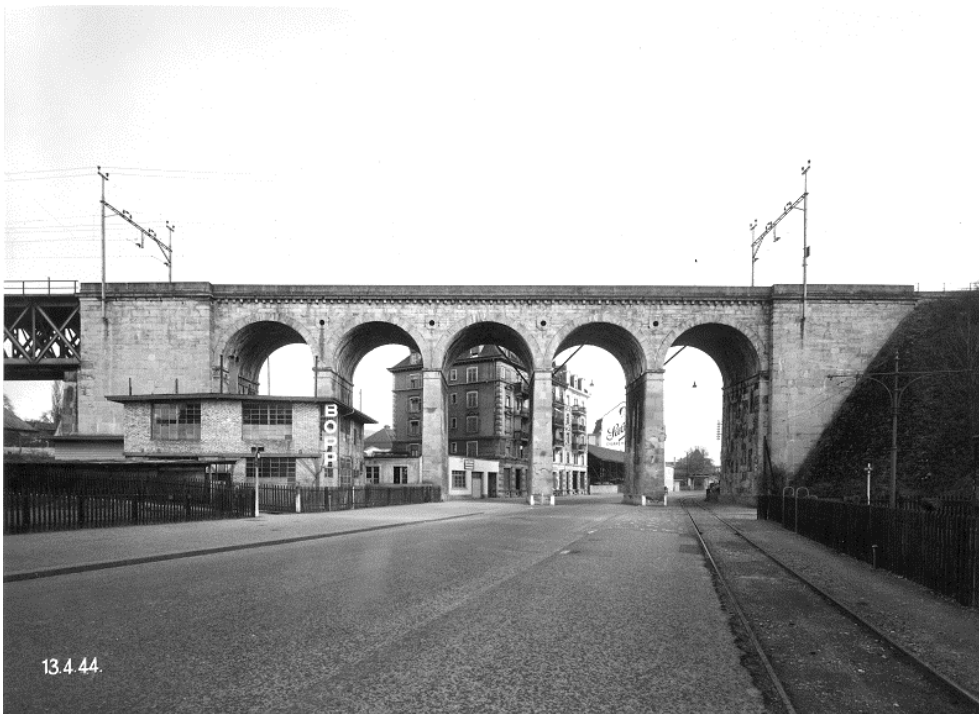
Wipkinger Viadukt, ehem. Strassenunterführung Sihlquai (abgebrochen), Ansicht von W, Bild: Baugeschichtliches Archiv Zürich, Bild Nr. 18787, 13.04.1944, (Bild Nr. D101353_75).
