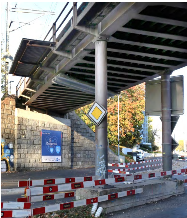
Strassenunterführung Badenerstrasse, die beiden Pendelstützen in Strassenmitte und das westliche Widerlager im Hintergrund, 25.10.2018 (Bild Nr. D101354_46).
