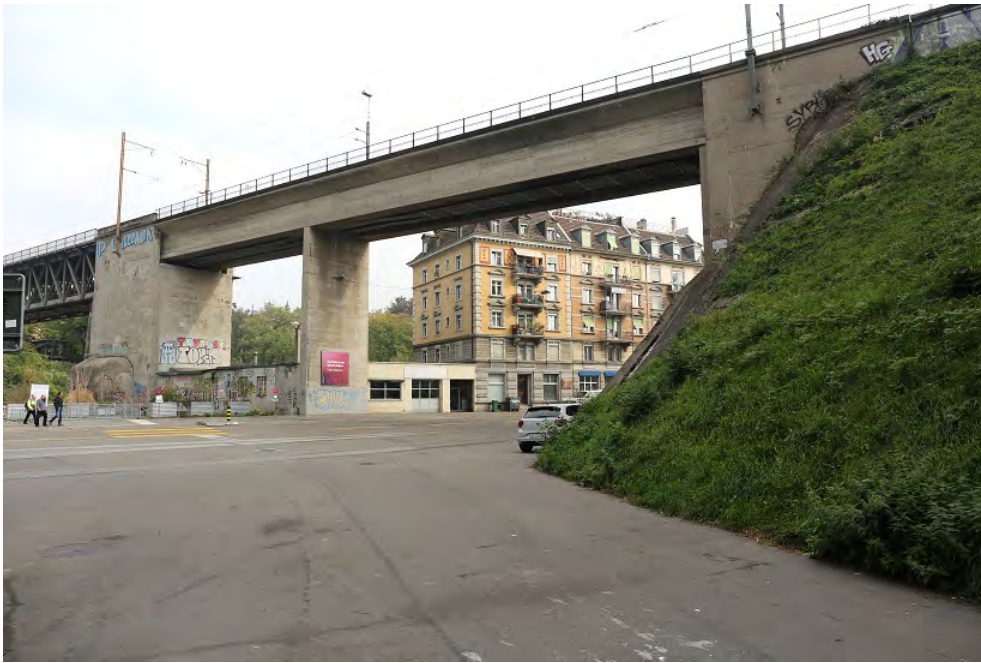
Wipkinger Viadukt, Strassenunterführung Sihlquai (Ersatzneubau von 1955), Ansicht von W, 20.10.2018 (Bild Nr. D101353_77).
