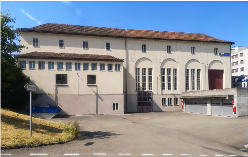
Unterwerk Seebach, Dienstgebäude, Ansicht von NO, 01.07.2019 (Bild Nr. D101382_02).
