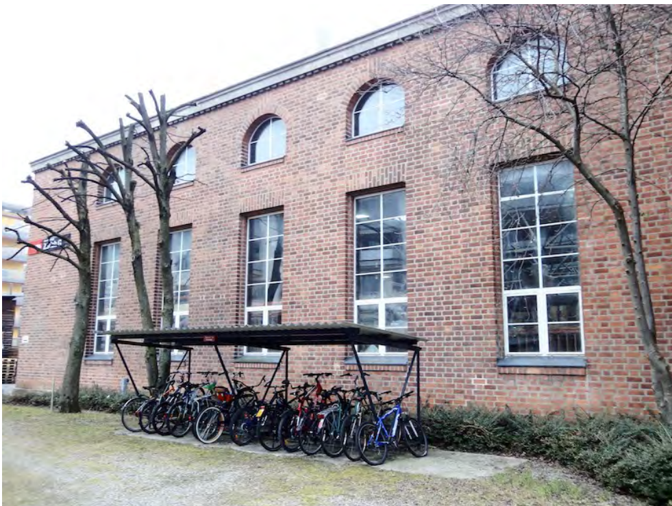
«Lokomotivremise G», Schiebebühnenhalle West (261AUSCHIEB04007-1), Ansicht von NW, 26.01.2017 (Bild Nr. D101395_07).
