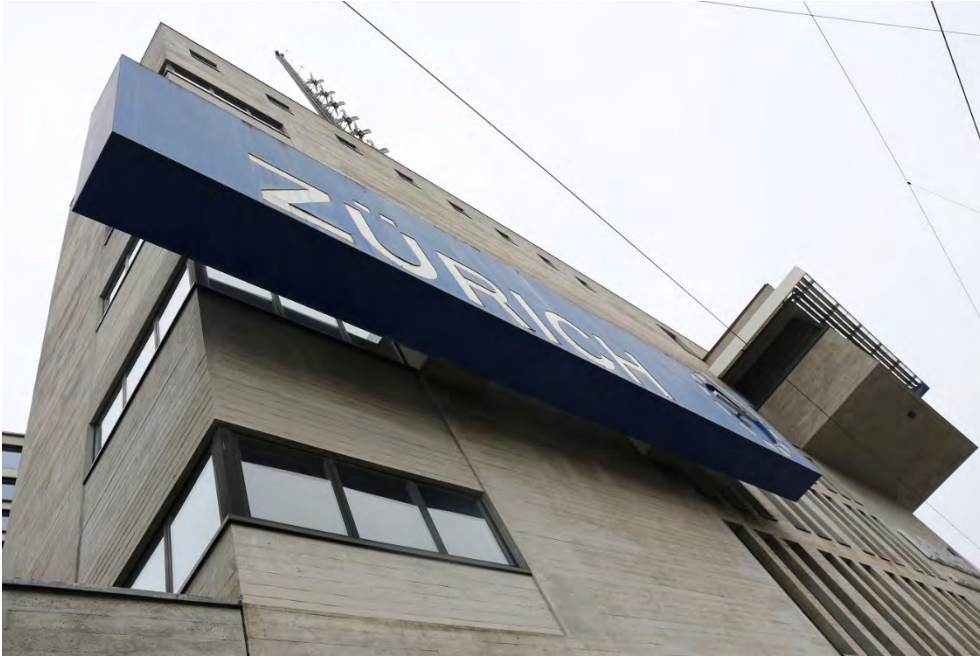
Stellwerke, Zentralstellwerk (261AU00932), Nordostecke, 15.12.2018 (Bild Nr. D101139_30).
