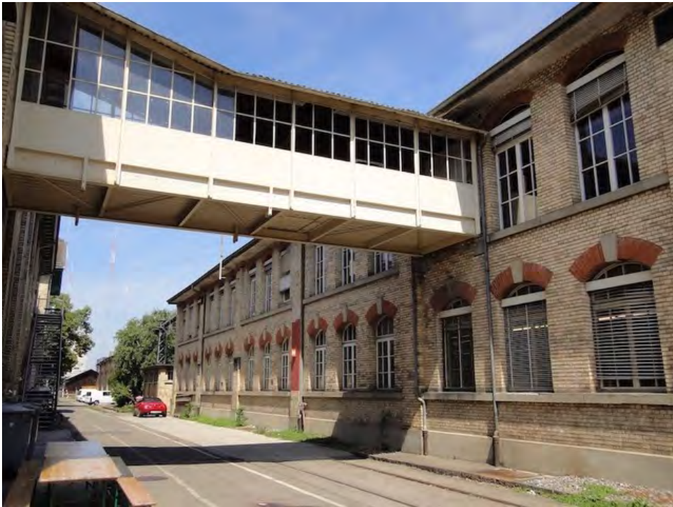
Hauptwerkstätten, Wagenwerkstätte I (261AU03362), Südwestfassade mit Passerelle zum Speisehaus (261AU03290) über der Werkstrasse (261AUUMGEBU00001), 17.07.2019 (Bild Nr. D101369_28).
