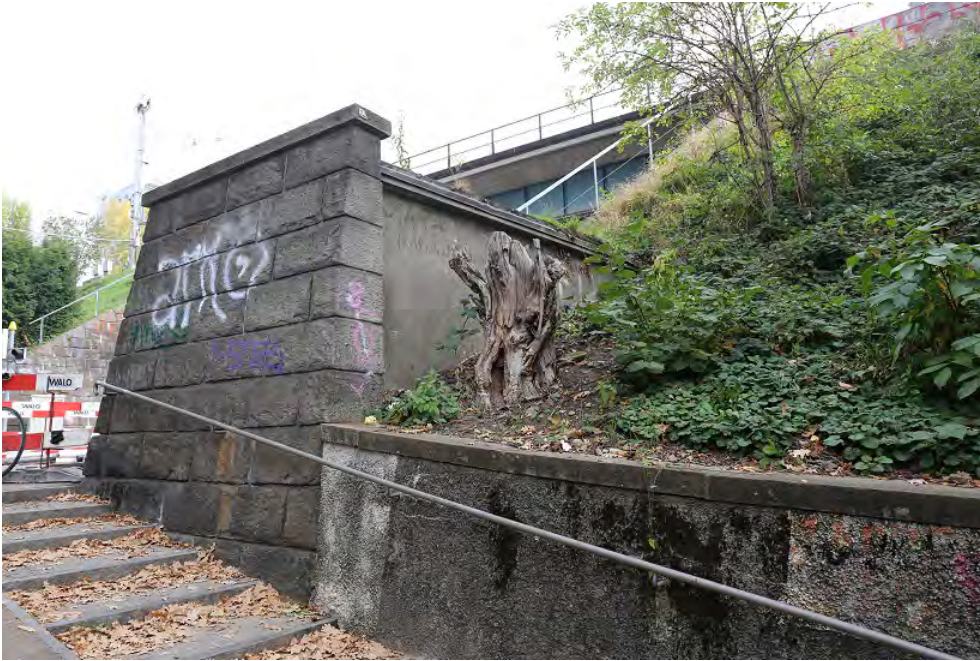
Wipkinger Viadukt, Erddamm Wasserwerkstrasse (261WPDAMM00001) und Pissoir (261WPPISSOIR00001), Ansicht von SW, 20.10.2018 (Bild Nr. D101353_87).
