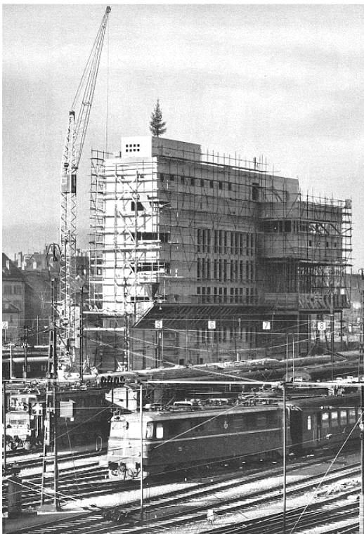
Stellwerke, Zentralstellwerk (261AU00932) im Bau, aus: Schweizerische Bundesbahnen SBB, Geschäftsbericht, 1961, S. 2., Archiv SBB AG, (Bild Nr. D101139_41).
