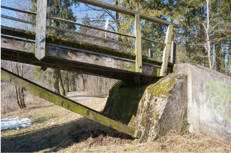
Fussgängersteg «Chinesenbrüggli», nördliches Widerlager, Ansicht von O, 15.02.2015 (Bild Nr. D101067_05).
