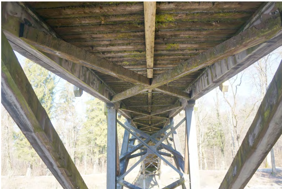
Fussgängersteg «Chinesenbrüggli», Gehweguntersicht und Tragwerk, 15.02.2015 (Bild Nr. D101067_09).
