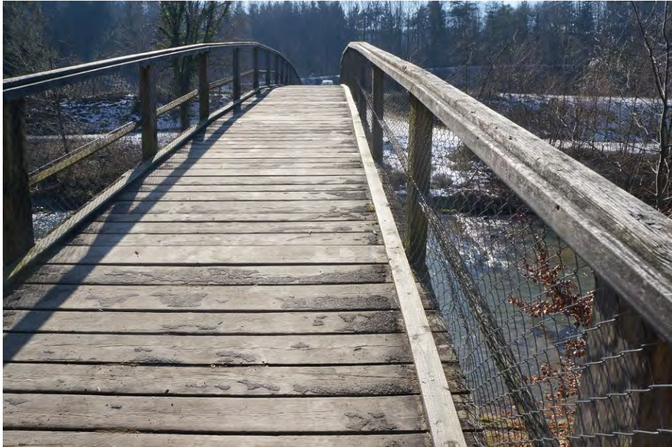
Fussgängersteg «Chinesenbrüggli», Gehweg, Ansicht von N, 15.02.2015 (Bild Nr. D101067_07).
