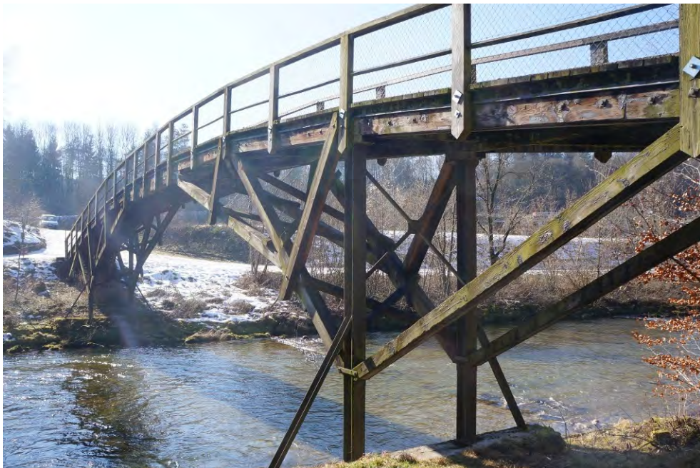
Fussgängersteg «Chinesenbrüggli», Ansicht von NO, 15.02.2015 (Bild Nr. D101067_03).
