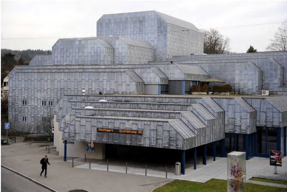
Theater Winterthur und Umgebungsgestaltung, Ansicht von W, 01.01.2014 (Bild Nr. D100623_01).
