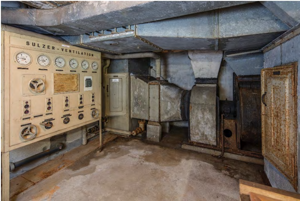
Frei- und Hallenbad mit Gartenanlage, Hallenbad- und Sporttrakt, bauzeitliche technische Ausstattung im UG, 06.06.2017 (Bild Nr. D101532_45).
