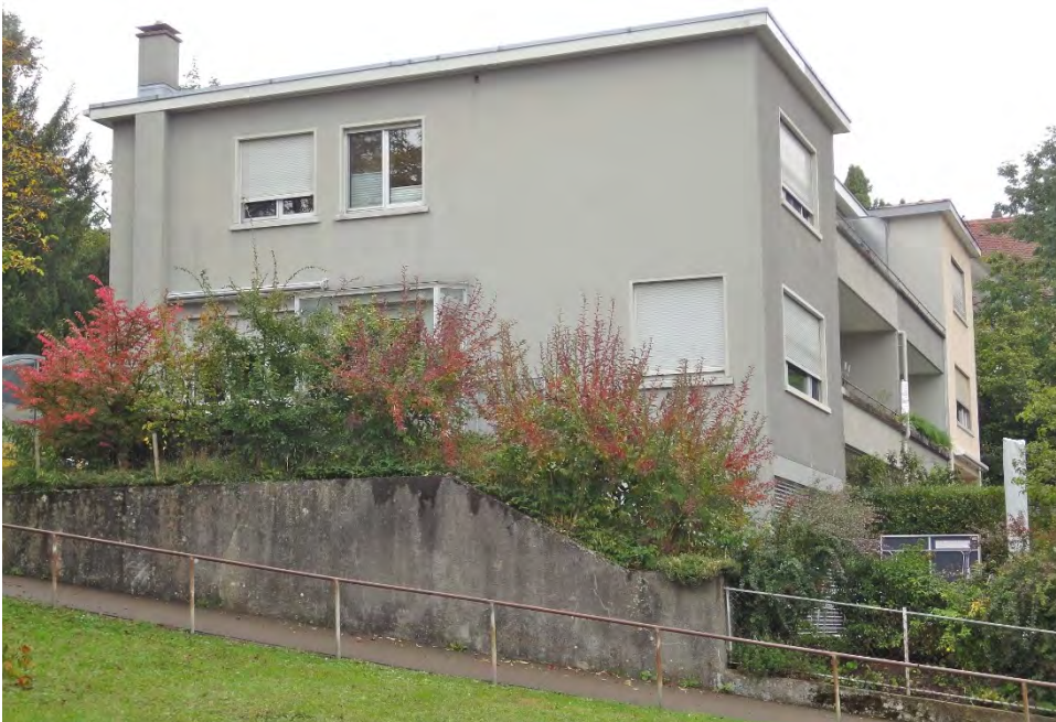
Reihenhäuser Brühlberg- und Mythenstrasse, Häuser an der Brühlbergstrasse (vorne links Vers. Nr. 04513), Ansicht von S, 09.10.2013 (Bild Nr. D101133_44).
