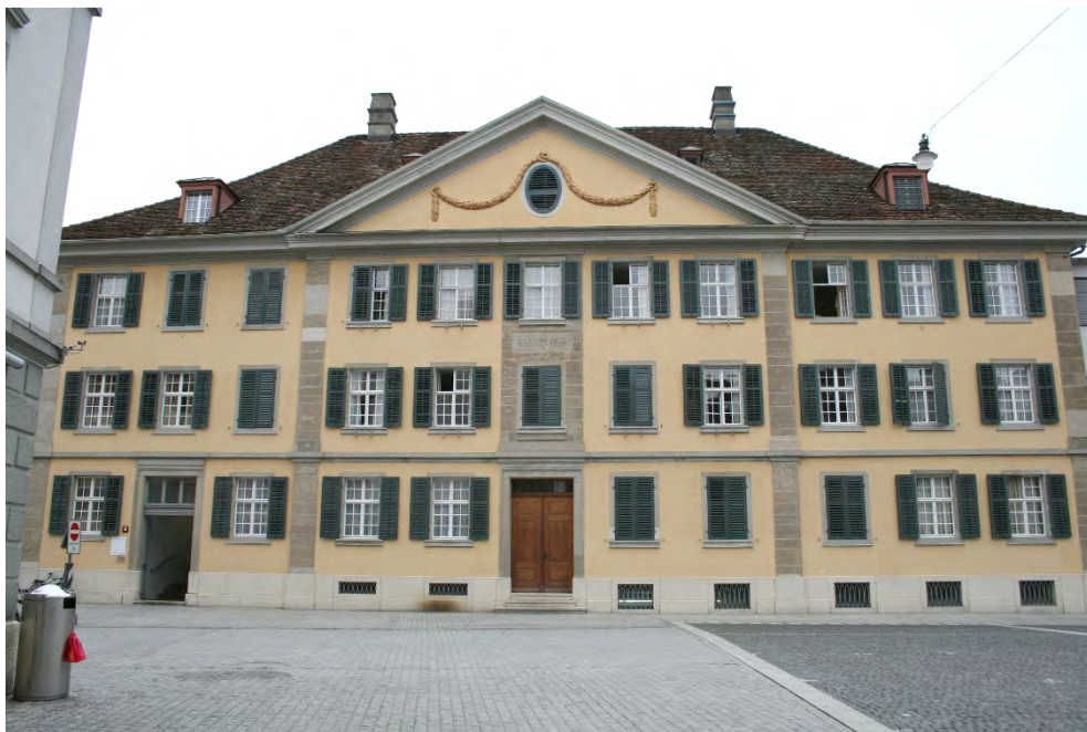
Altersheim, ehem. «Unterer Spital» und Brunnen, Ansicht von W, 21.03.2017 (Bild Nr. D101130_94).
