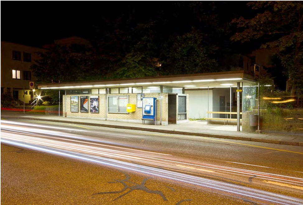
Buswartehäuschen Breite, Ansicht von NW, 23.09.2013 (Bild Nr. D101137_03).
