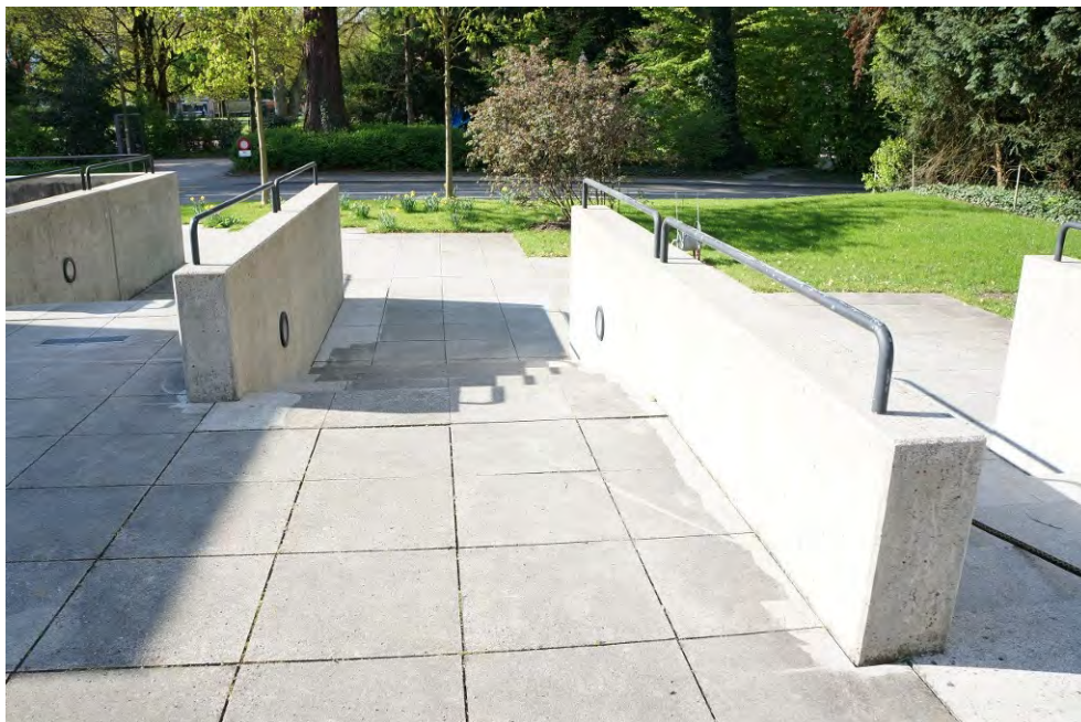
Theater Winterthur und Umgebungsgestaltung, Eingangstreppe im S, Ansicht von N, 15.04.2014 (Bild Nr. D100623_39).
