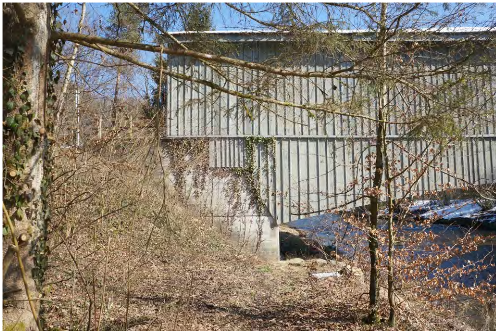
Holzbrücke, ehem. Brunibrücke, nördliches Widerlager, Ansicht von W, 25.02.2015 (Bild Nr. D101065_05).
