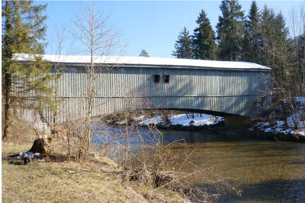
Holzbrücke, ehem. Brunibrücke, Ansicht von W, 25.02.2015 (Bild Nr. D101065_02).
