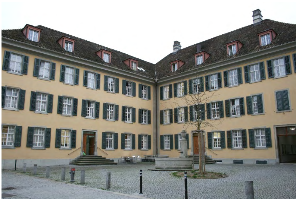
Altersheim, ehem. «Unterer Spital» und Brunnen, Ansicht von NO, 21.03.2017 (Bild Nr. D101130_95).
