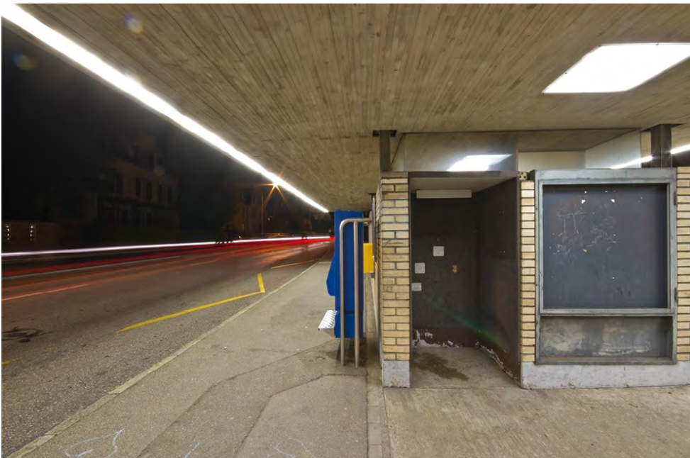
Buswartehäuschen Breite, Gedeckte Wartehalle mit Abortanlage, 23.09.2013 (Bild Nr. D101137_04).
