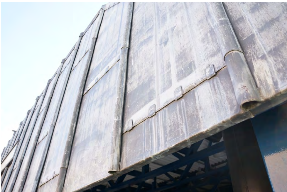
Theater Winterthur und Umgebungsgestaltung, Bleiverkleidung (Detail), 15.04.2014 (Bild Nr. D100623_04).
