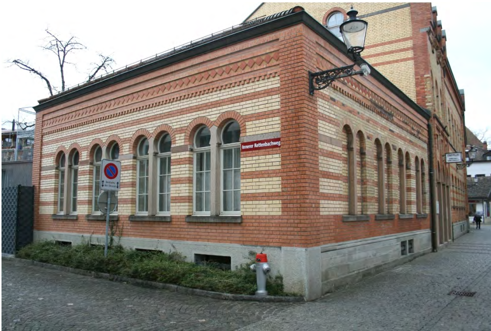
Ehem. Bade- und Waschanstalt, Ansicht von SW, 28.02.2017 (Bild Nr. D101128_31).
