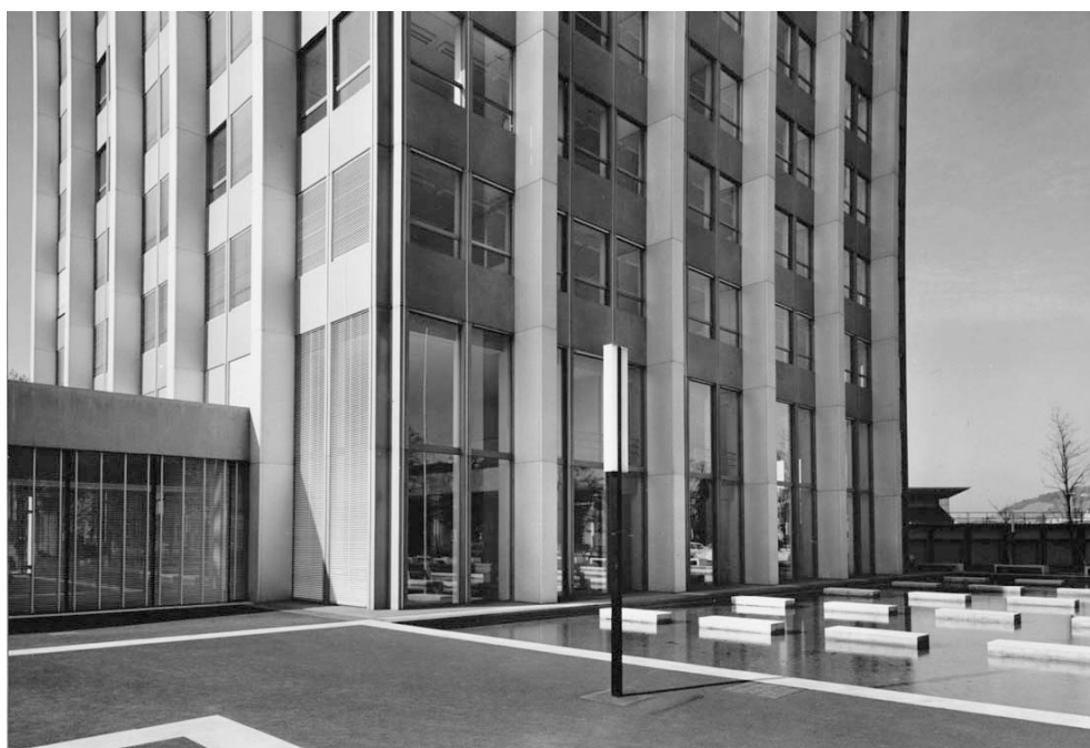
«Wintower», ehem. Verwaltungsgebäude der Gebr. Sulzer AG und Umgebungsgestaltung, südöstliche Gebäudeecke und Umgebungsgestaltung mit bauzeitlichem Bodenbelag, Wasserbecken, Betonelementen und Lampen, Ansicht von O, aus: Schweizerisches Wirtschaftsarchiv Basel, Nachlass Suter & Suter, Planmappe Umgebungsarbeiten, 01.01.1966 (Bild Nr. D100609_25).
