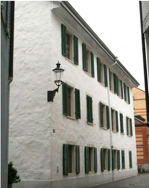
«Lörlibad», Ansicht von W, 21.03.2017 (Bild Nr. D101130_69).
