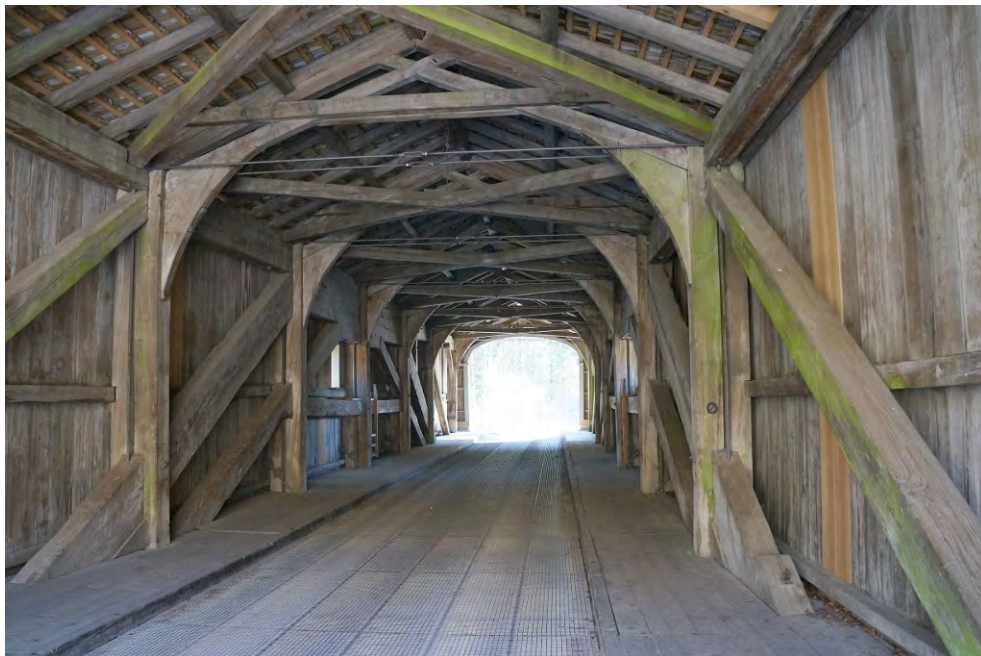
Holzbrücke, ehem. Brunibrücke, Trottoirs, Fahrbahn und offene Dachkonstruktion, Ansicht von N, 25.02.2015 (Bild Nr. D101065_10).
