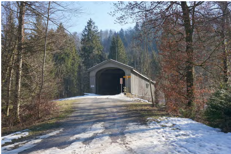
Holzbrücke, ehem. Brunibrücke, Ansicht von N, 25.02.2015 (Bild Nr. D101065_03).
