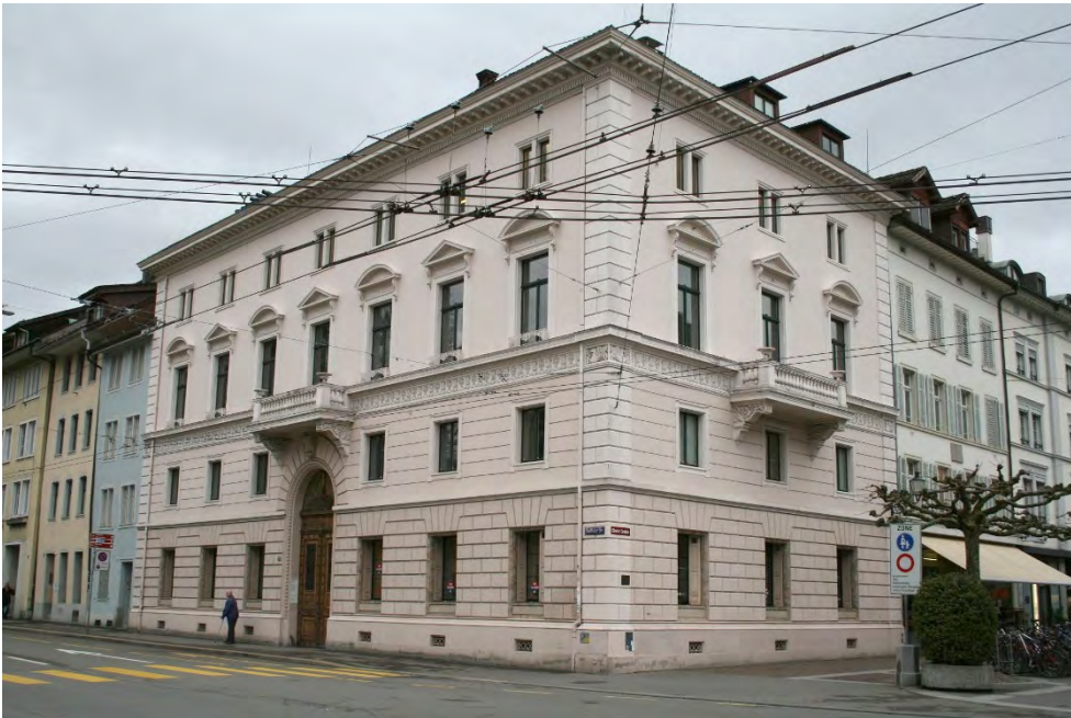
Geschäftshaus «Warteck», Ansicht von NW, 28.02.2017 (Bild Nr. D101130_74).
