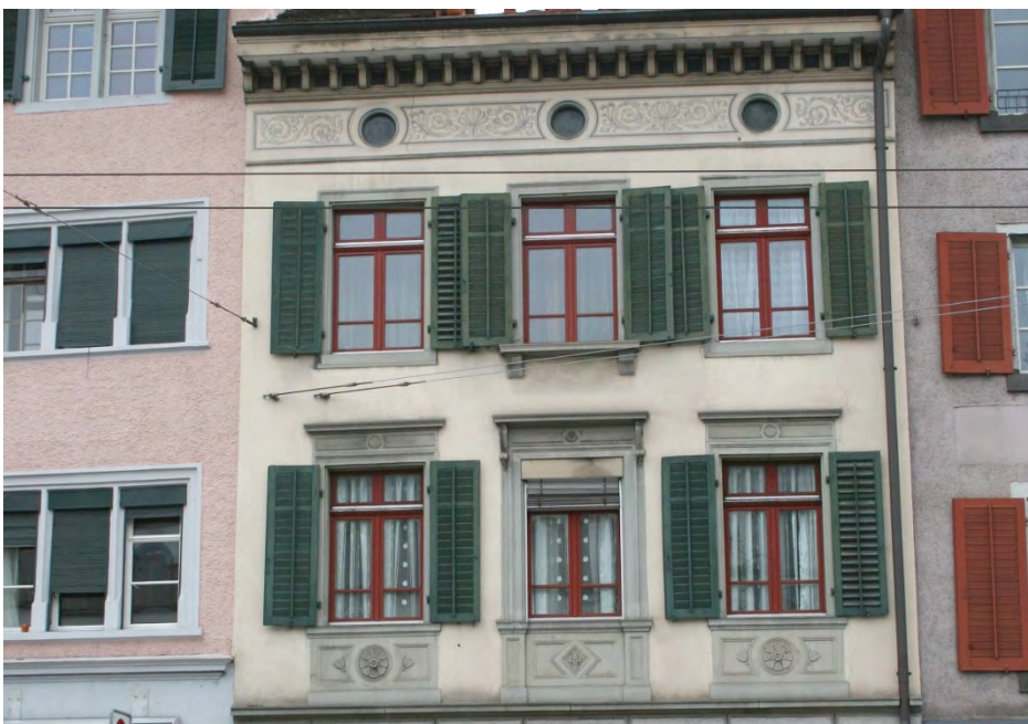
Haus «Zum hinteren Waldhorn», 1. und 2. OG sowie Mezzaninbereich der Südfassade, 21.03.2017 (Bild Nr. D101130_76).
