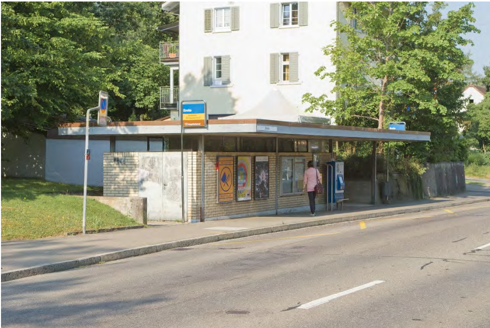
Buswartehäuschen Breite, Ansicht von NO, 28.05.2010 (Bild Nr. D101137_02).
