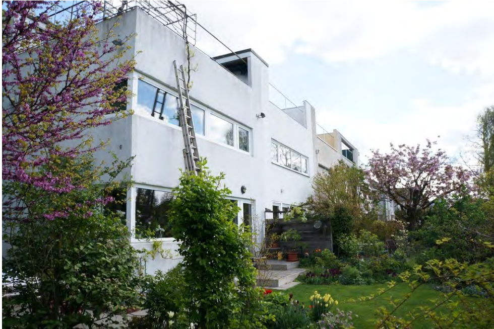
Siedlung Leimenegg, Mehrfamilienhaus, Gärten, Ansicht von SW, 15.04.2014 (Bild Nr. D100633_12).
