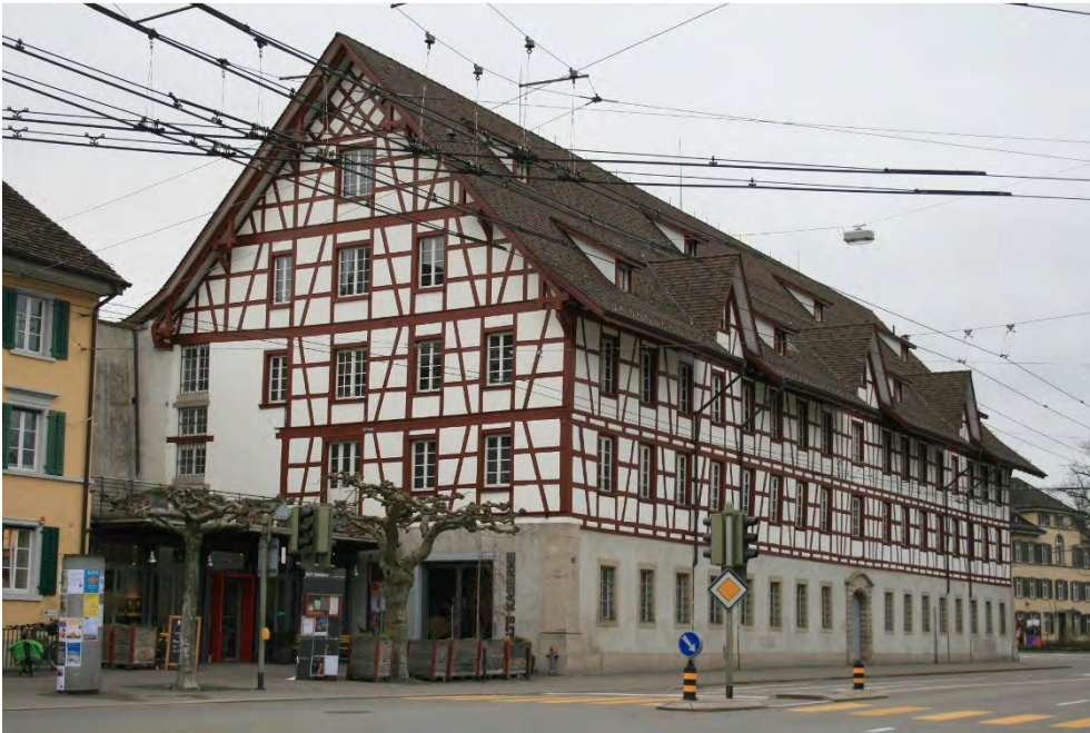
«Alte Kaserne», Ansicht von W, 21.03.2017 (Bild Nr. D101135_01).
