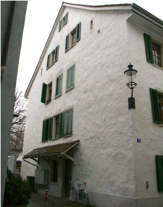
«Lörlibad», Ansicht von W, 21.03.2017 (Bild Nr. D101130_68).
