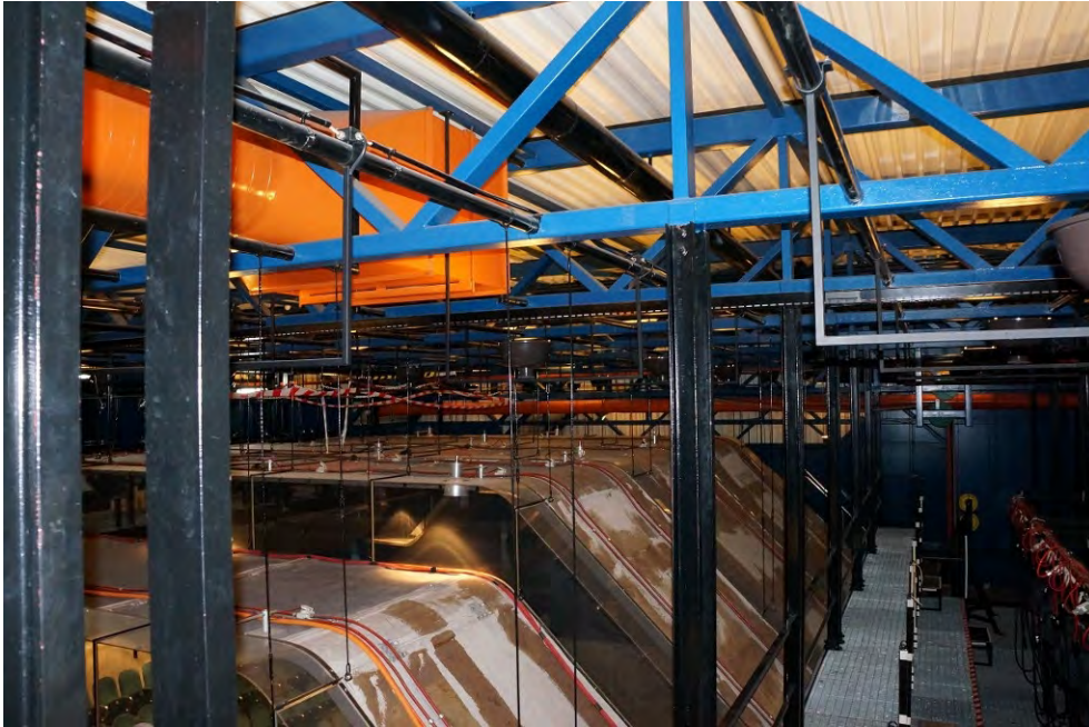
Theater Winterthur und Umgebungsgestaltung, Zuschauerraum, abgehängte Eisenbetonlamellen und Technikbrücken, 15.04.2014 (Bild Nr. D100623_22).
