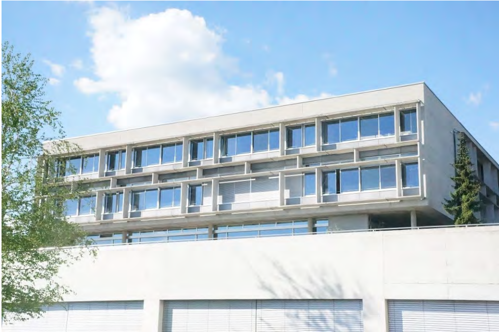
Erweiterungsbauten der Kantonsschule Rychenberg und Umgebungsgestaltung, Erweiterungsbau I (Vers. Nr. 06120), Ansicht von SO, 19.05.2014 (Bild Nr. D100616_64).
