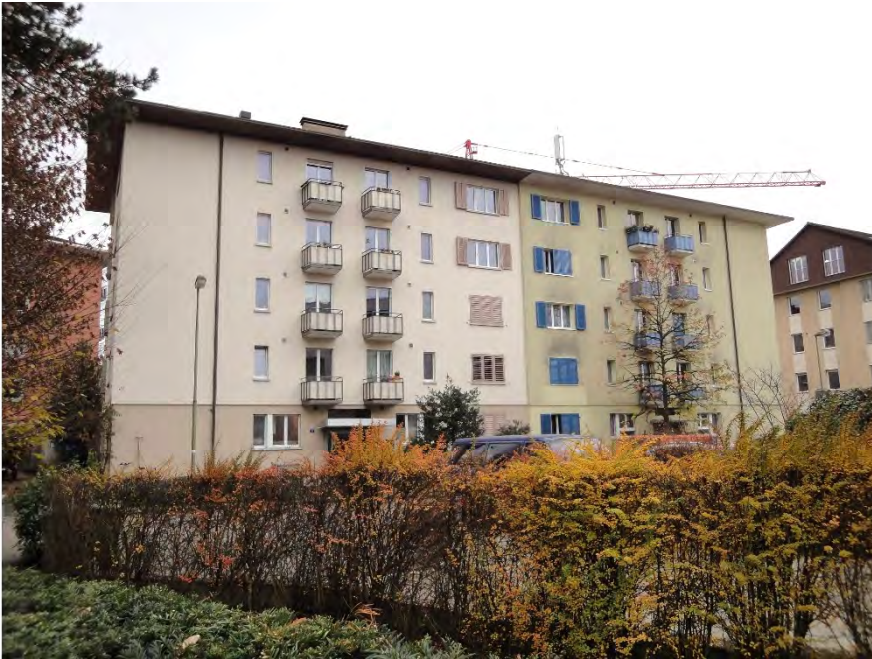
Wohnüberbauung «Brunnergut», Strassenfassaden Kreuzstrasse (Vers. Nr. 05993, 05994), 21.11.2016 (Bild Nr. D101133_52).
