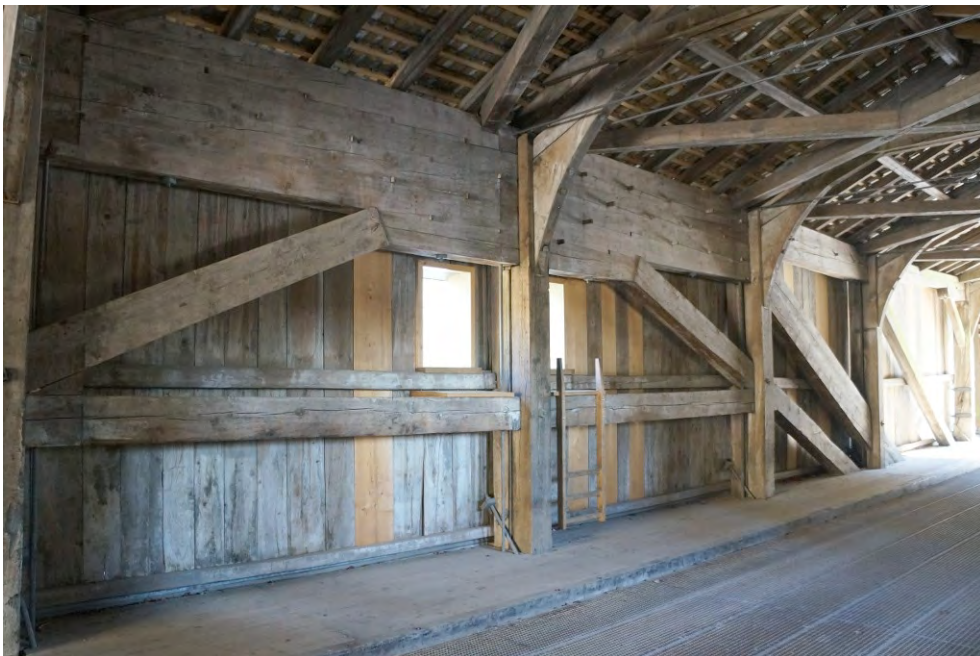
Holzbrücke, ehem. Brunibrücke, westliche Trauffassade mit vierfacher Sprenghängewerkkonstruktion, zwei Fenster, teils bauzeitliche und teils erneuerte Bretter sowie offener Dachstuhl, 25.02.2015 (Bild Nr. D101065_14).
