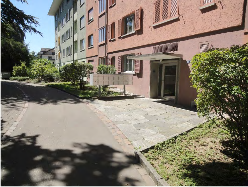
Wohnüberbauung «Brunnergut», Vorgartenbereich an der Lindstrasse, Ansicht von N, 20.07.2016 (Bild Nr. D101133_56).
