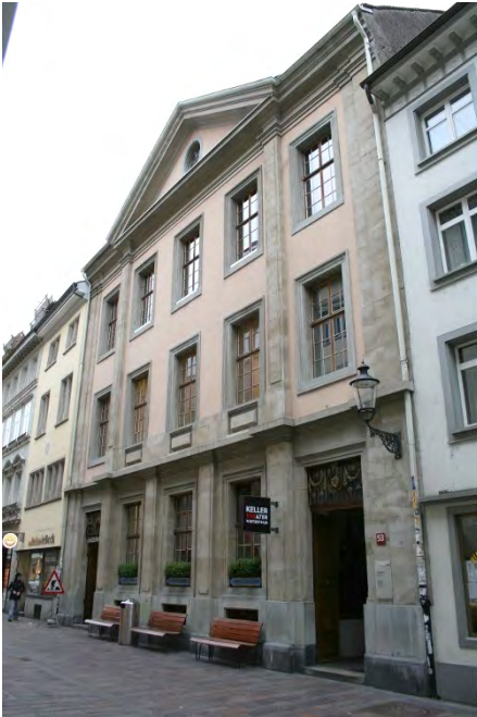
«Altes Stadthaus», ehem. Kranken- und Pfrundhaus, Ansicht von NW, 22.06.2017 (Bild Nr. D101134_72).
