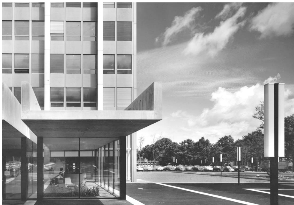
«Wintower», ehem. Verwaltungsgebäude der Gebr. Sulzer AG und Umgebungsgestaltung, südöstliche Gebäudeecke und Umgebungsgestaltung mit bauzeitlichem Bodenbelag, Wasserbecken, Betonelementen und Lampen, Ansicht von SO, aus: Schweizerisches Wirtschaftsarchiv Basel, Nachlass Suter & Suter, Planmappe Umgebungsarbeiten, 01.01.1966 (Bild Nr. D100609_24).
