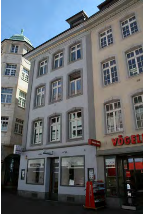
Haus «zu den drei Blumen», Ansicht von NW, 26.08.2016 (Bild Nr. D101113_62).
