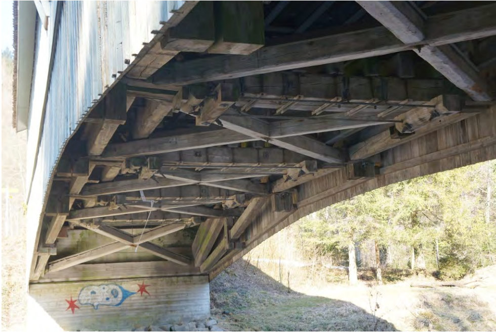
Holzbrücke, ehem. Brunibrücke, verstärktes Tragwerk und nördliches Widerlager, 25.02.2015 (Bild Nr. D101065_13).
