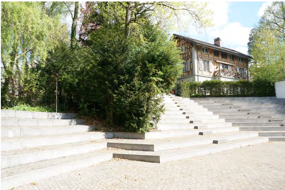
Musikkonservatorium und Umgebungsgestaltung, Sitzstufenanlage und ehem. Ökonomiegebäude (Vers. Nr. 00685), 15.04.2014 (Bild Nr. D100622_17).
