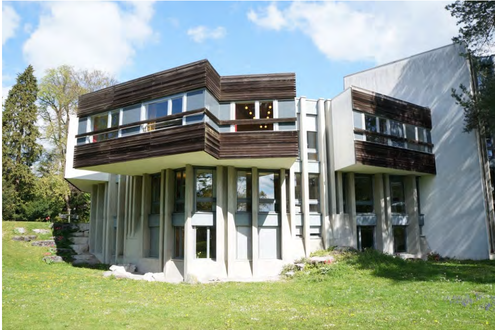
Musikkonservatorium und Umgebungsgestaltung, Musikkonservatorium, Ansicht von SO, 15.04.2014 (Bild Nr. D100622_14).
