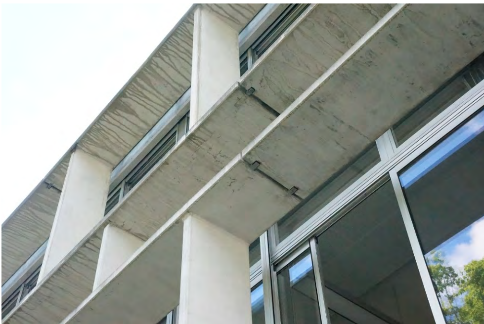
Erweiterungsbauten der Kantonsschule Rychenberg und Umgebungsgestaltung, Erweiterungsbau I, Ostfassade mit vorgehängten Betonelementen (Detail), 19.05.2014 (Bild Nr. D100616_35).
