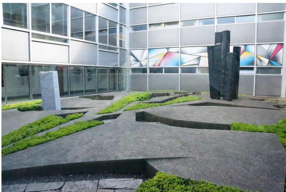
Erweiterungsbauten der Kantonsschule Rychenberg und Umgebungsgestaltung, Erweiterungsbau I, südlicher Innenhof, 19.05.2014 (Bild Nr. D100616_38).
