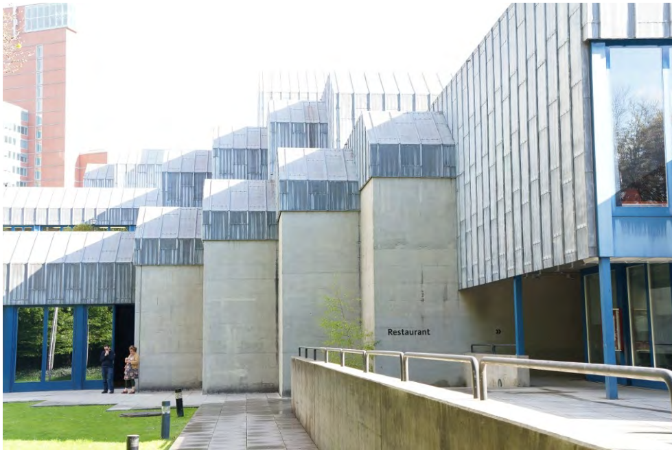
Theater Winterthur und Umgebungsgestaltung, Ansicht von S, 15.04.2014 (Bild Nr. D100623_40).
