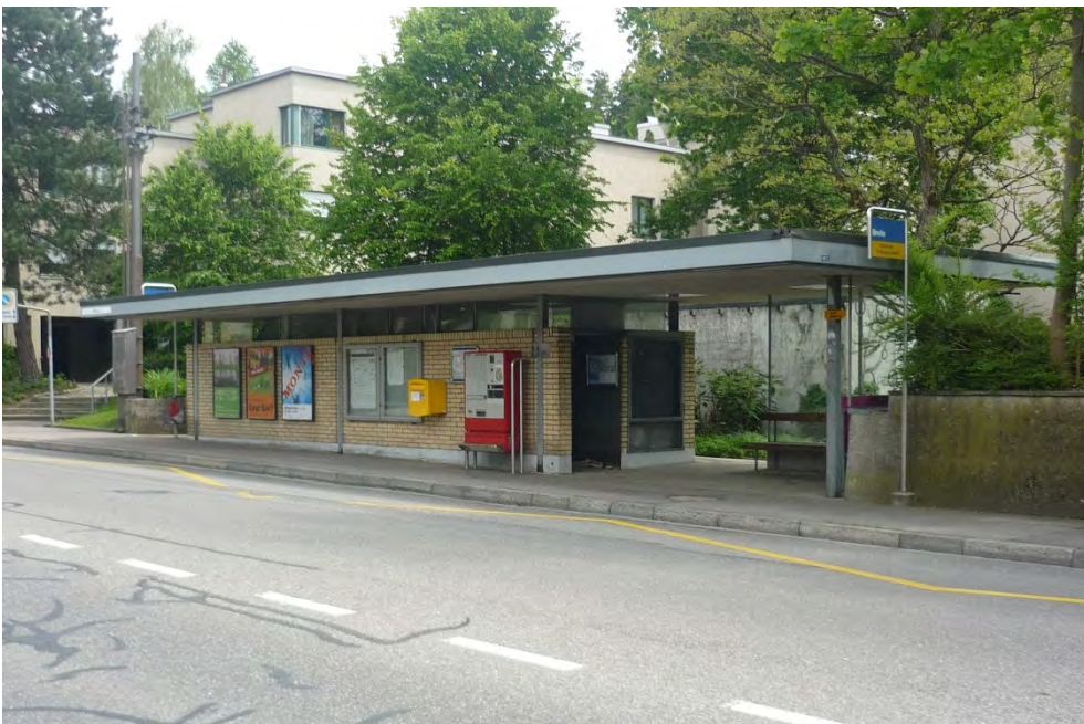
Buswartehäuschen Breite, Ansicht von NW, 28.05.2010 (Bild Nr. D101137_01).
