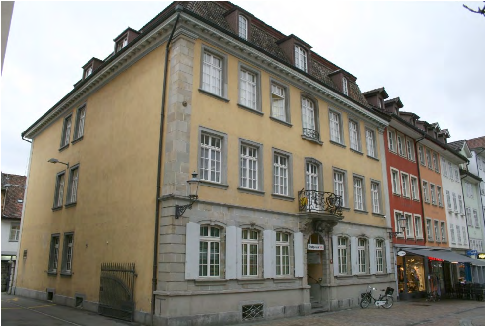
Haus «Zum Adler», Ansicht von NO, 22.06.2017 (Bild Nr. D101130_71).
