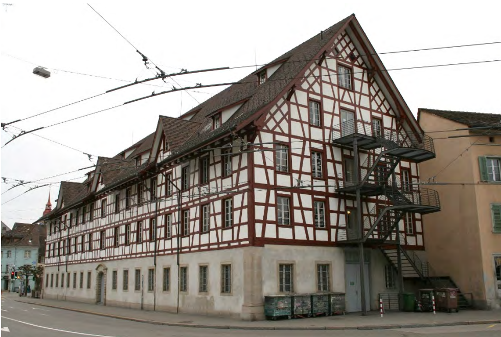
«Alte Kaserne», Ansicht von SO, 21.03.2017 (Bild Nr. D101135_03).
