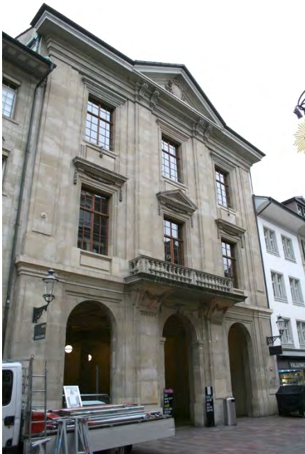
Rathaus, Ansicht von S, 21.03.2017 (Bild Nr. D101134_50).
