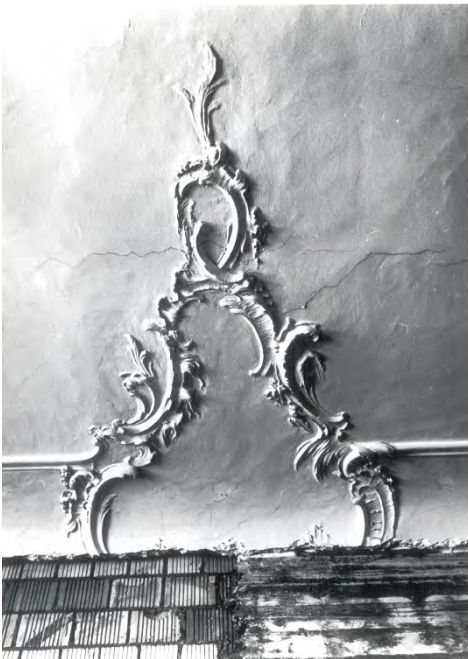
Wohnhaus «Zur Insel», Stuckatur im 3. OG, 07.04.1971 (Bild Nr. D100538_03).
