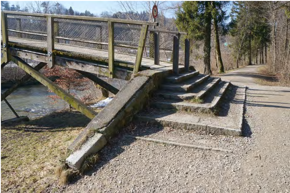
Fussgängersteg «Chinesenbrüggli», nördliches Widerlager, Ansicht von NO, 15.02.2015 (Bild Nr. D101067_06).
